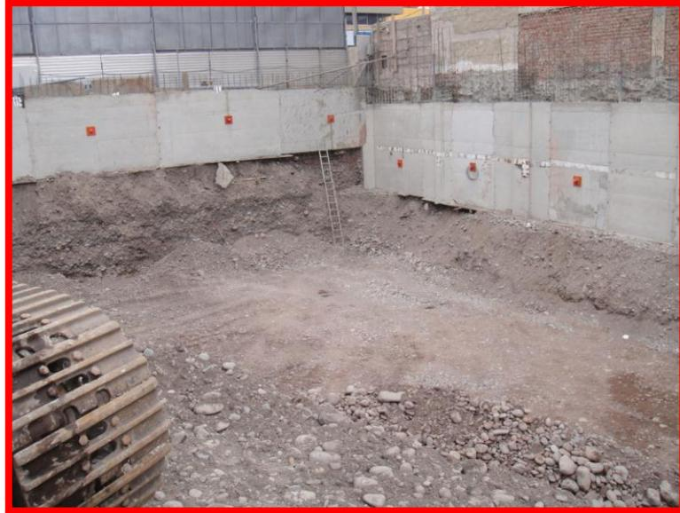
**FOTO 49: Concluidos todos los paños de la primera hilada completando todos los pasos descritos desde el ítem 6.1 hasta el 6.12 se realiza la Excavación Masiva de la Segunda Hilada donde se han dejado las banquetas perimetrales, siguiendo el mismo procedimiento.**
