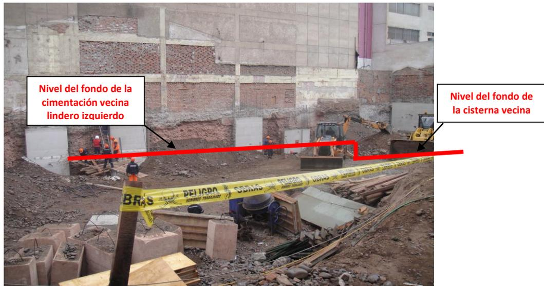
**Foto 13: Nótese el perfil de cimentación del edificio de 8 pisos colindante por el lindero izquierdo (Primera Hilada). Al fondo baja el nivel de fondo de cimentación por la cisterna existente**
