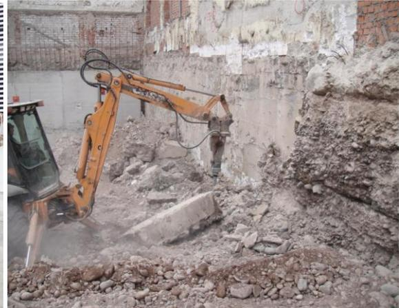
**FOTO 23: Pequeño Cargador Frontal con Retroexcavadora. El accesorio de la cuchara de la excavadora puede cambiarse por un martillo. FOTO 24: Se observa al Martillo demoliendo las calzaduras hechas por el vecino.**
