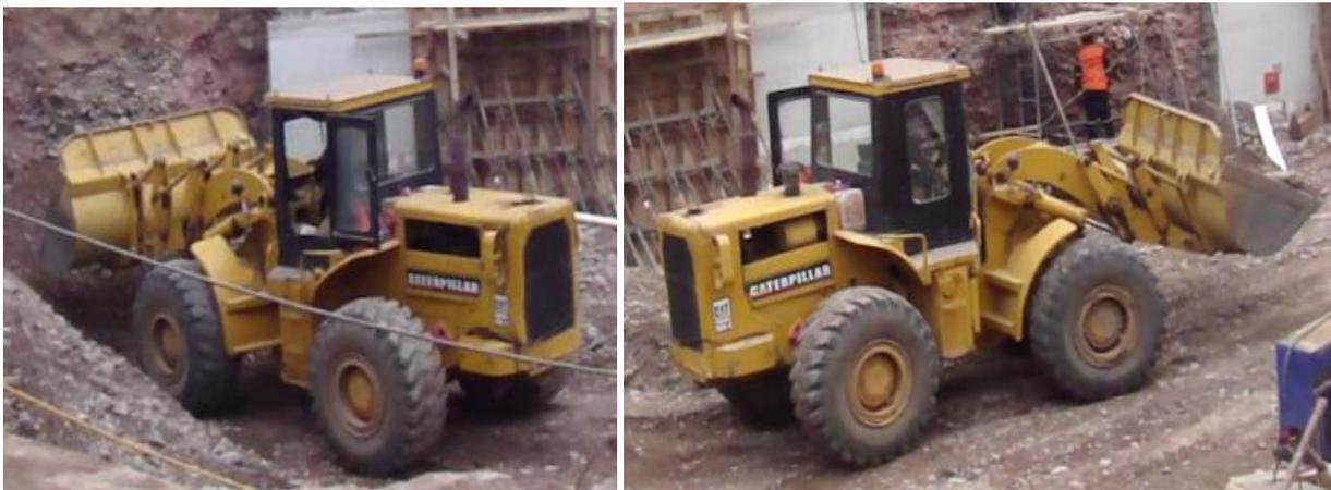
**Fotos 6 y 7: 2° Paso: Excavación, Preparación y perfilado de la banqueta con cargador frontal para el anclaje**
