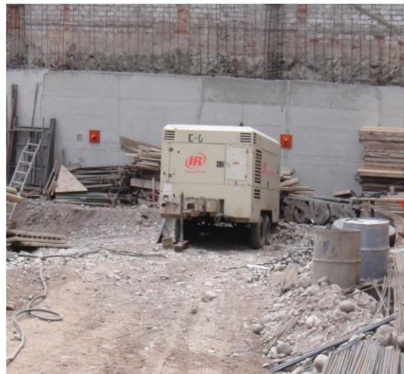
**Fotos 34 y 35: Bomba Concretera para la lechada y Compresora**
