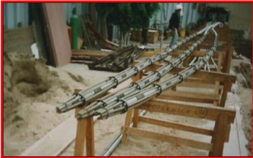
**FOTO 38: Cables de Acero para los Anclajes**
