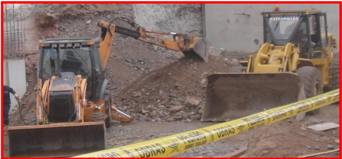
**FOTO 26: Trabajo combinado de la pequeña retroexcavadora con el cargador frontal**
