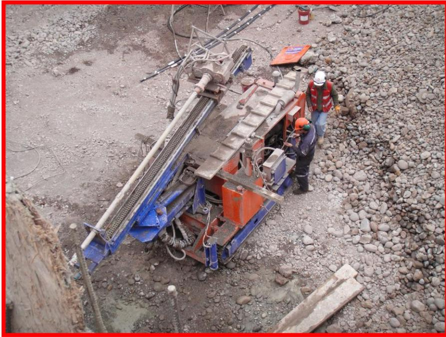
**FOTO 36: Perforación e Inyección de Anclajes**
