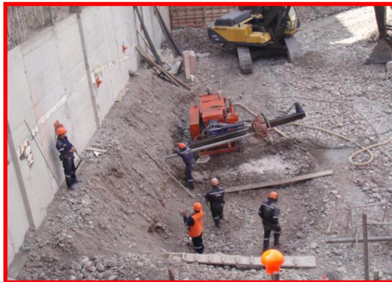
**FOTO 50: Perforación e Inyección de Anclajes en la Segunda Hilada**
