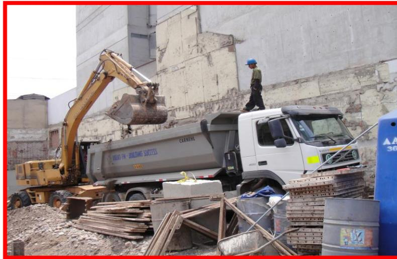
**FOTO 48: Excavación Masiva y Eliminación de Material Excedente en
