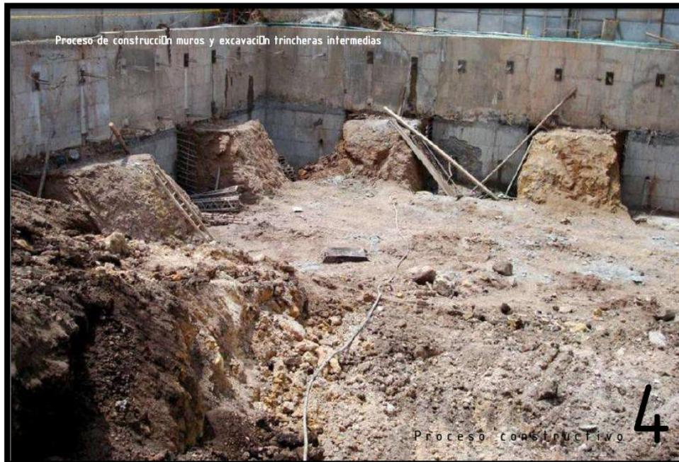
FOTO 12: Paso 8°: Excavación por paños alternados
