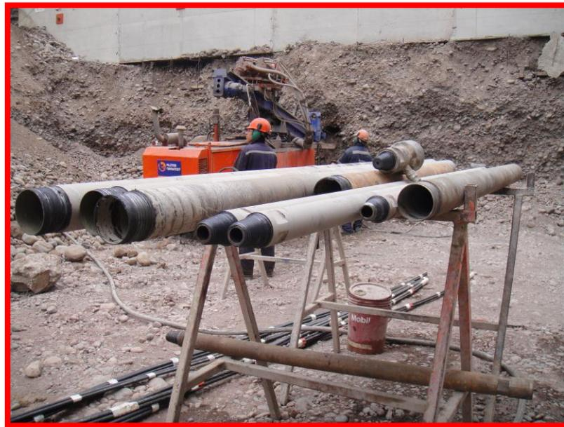
**FOTO 39: Tubos para perforar Anclajes**
