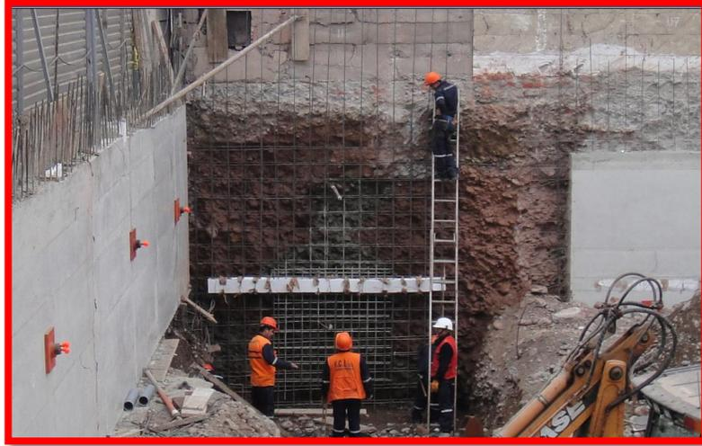
**Foto 47: Armado de acero con refuerzo adicional en la zona de anclaje.
