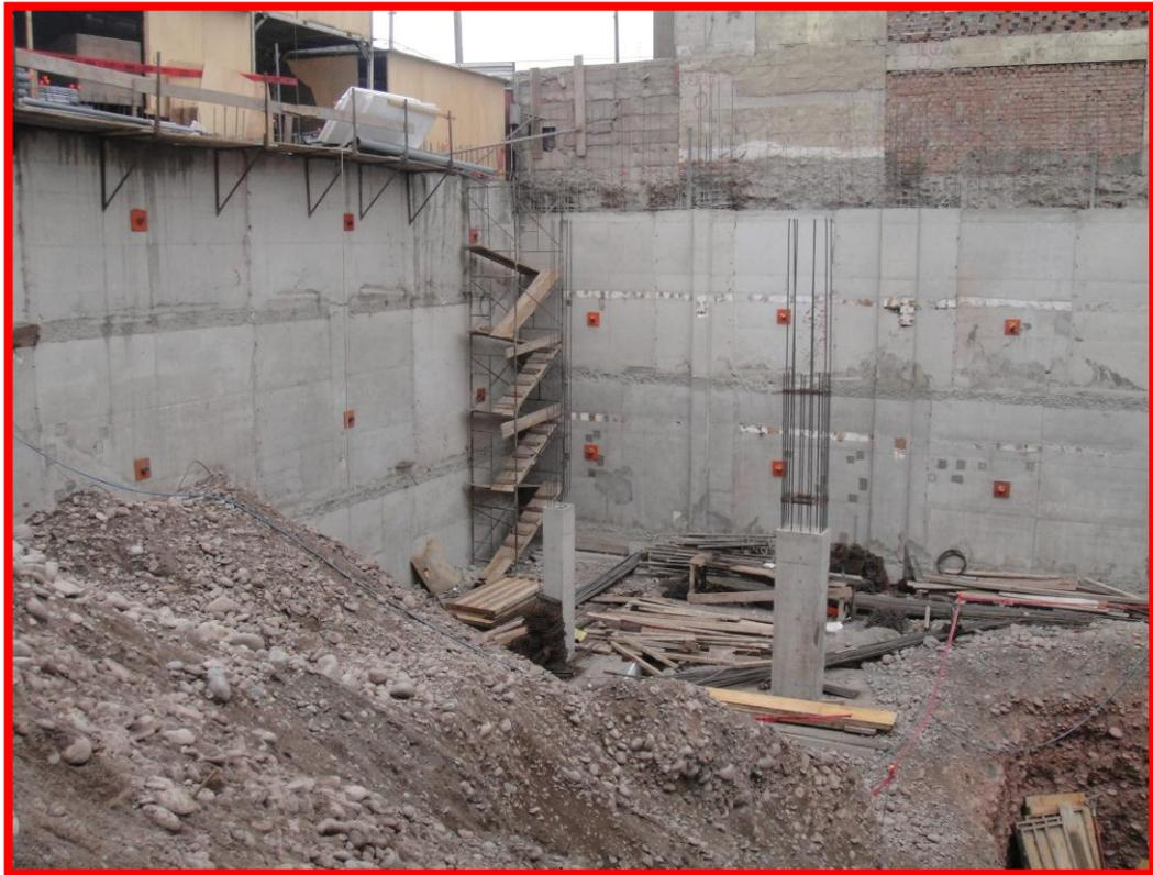
**FOTO 53: Muros anclados concluidos en dos niveles y el tercer nivel sin anclajes hasta la cimentación.**
