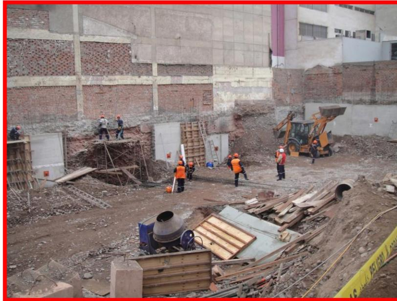
**FOTO 31: Edificio Monte Rosa: Nótese los paños vaciados del 1er anillo intercalados con las banquetas**
