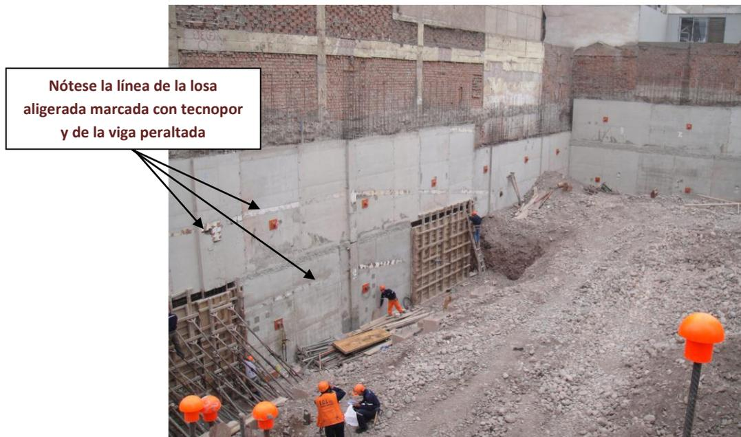
**FOTO 52: Se están concluyendo los vaciados de los paños de la segunda hilada. Nótese las ventanas en la parte alta del encofrado por donde se vaciará el concreto del paño colocando una tabla en forma diagonal donde se forma una rebaba de concreto denominada cachimba.**
