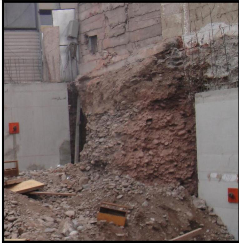
**FOTO 11: Corte donde se aprecia el perfil del terreno natural: típico conglomerado**
