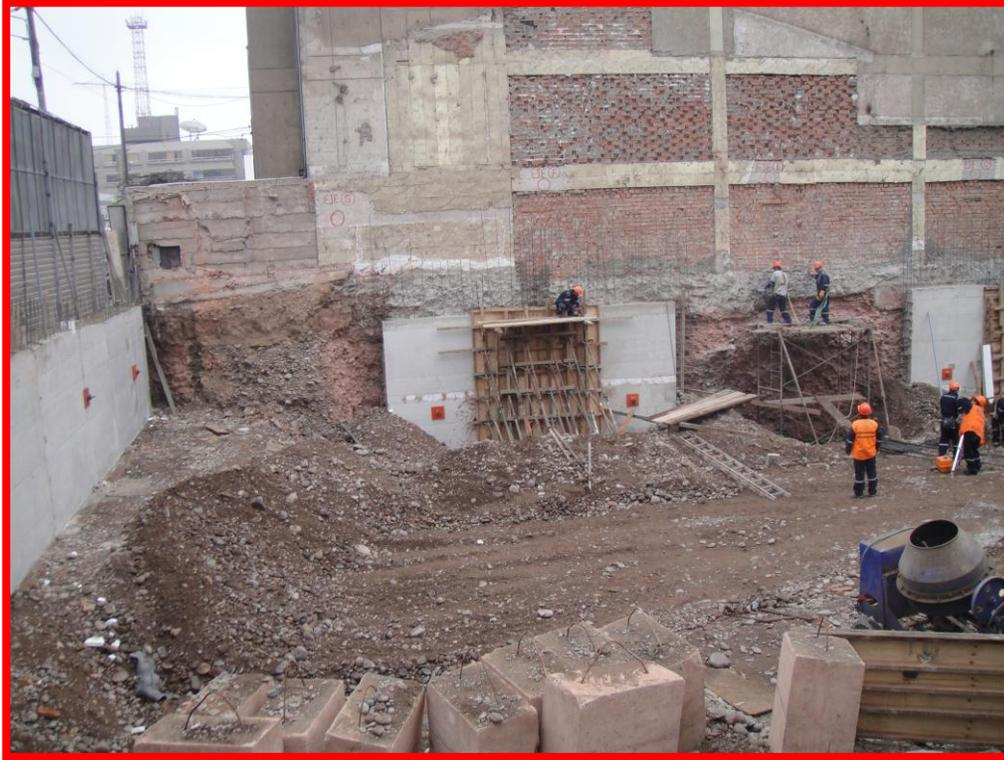
**FOTO 44: Encofrado y vaciado alternado de muros**
