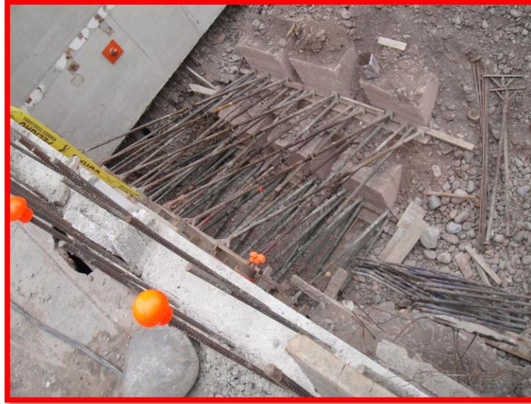
**FOTO 51: Encofrado de un paño en la Segunda Hilada**
