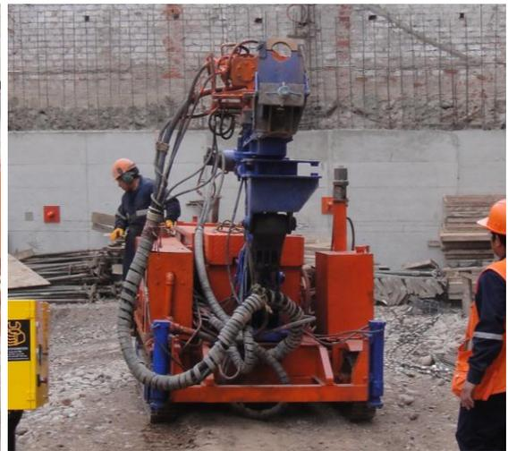
**Fotos 32 y 33: Movilización de Equipos a la obra por parte de la empresa Pilotes Terratest del Perú S.A.: Máquina perforadora e inyectora de concreto.**
