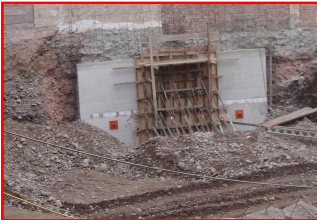
**FOTO 43: Encofrado paño entre anclajes 117 y 118. Obsérvese anclaje 117 tensado, requisito necesario para trabajar los paños adyacentes**
