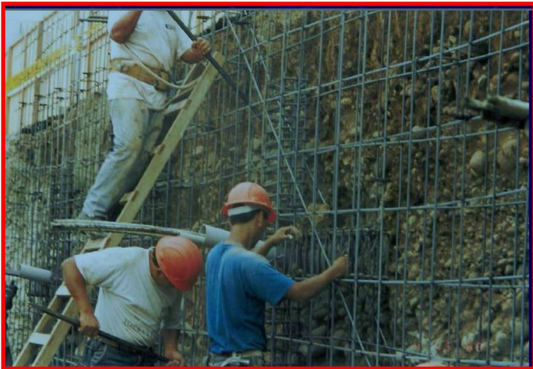
**FOTO 40: LUEGO DE HABER PERFORADO, INTRODUCIDO EL ANCLAJE E INYECTADO CONCRETO, SE CONTINÚA CON LA COLOCACIÓN DE LA ARMADURA DEL PAÑO DE MURO ANCLADO.**
