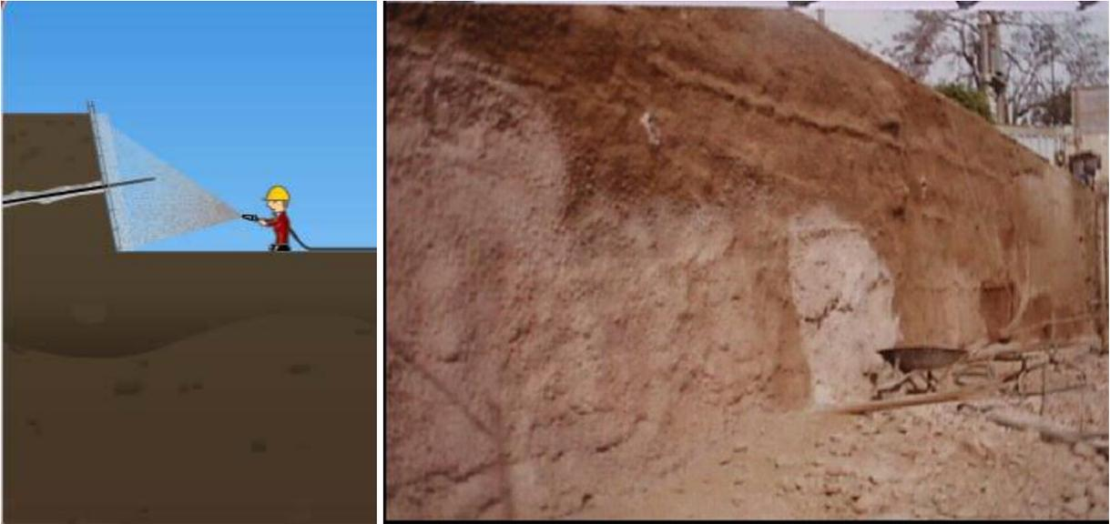
**3er Paso: Fig.19: Shotcrete para estabilizar talud y Foto 8: Pañeteo del Talud o Banqueta para estabilizarlo**
