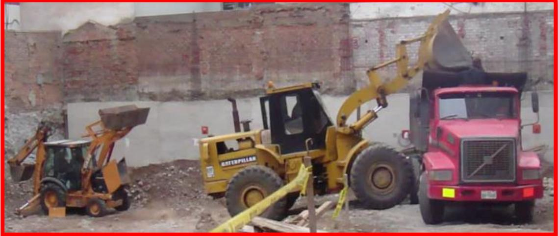
**Foto N° 18: Excavación Masiva del recinto de la primera hilada y Eliminación de Material Excedente**
