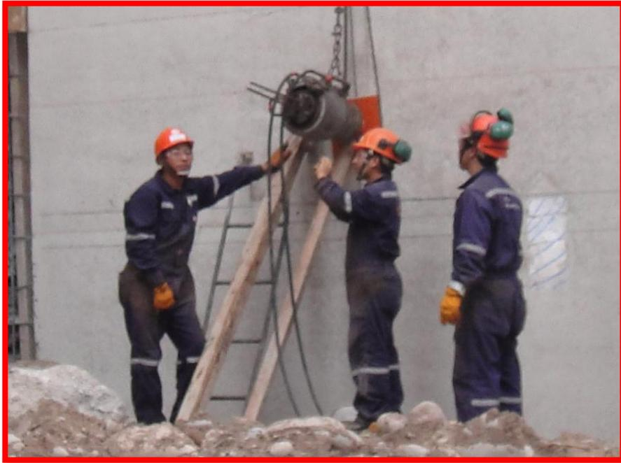
**FOTO 45: Tensado del Anclaje con Gata Hidráulica**
