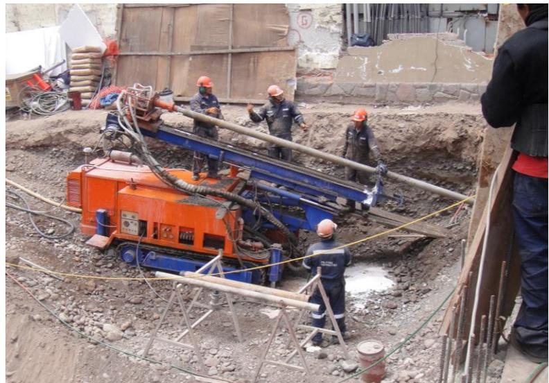
**Paso 4°: Figura N° 20: Perforación de anclaje y Foto 9: Perforación e Inyección para Anclaje de Muro**
