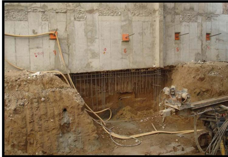
Foto 10: Paso 10°: Se ha colocado el refuerzo dejando mechas para futuros empalmes hacia abajo.
