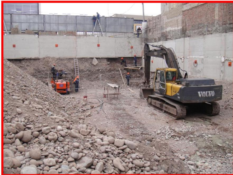
**FOTO 37: Perforación e Inyección de Anclajes sobre la banqueta**
