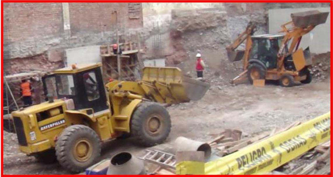
**FOTO 25: Cargador Frontal y Pequeño Cargador Frontal con Retroexcavadora en pleno trabajo de excavación de la primera hilada**
