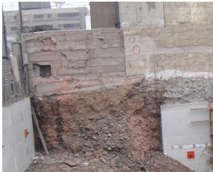
**Foto14: Cerco del edificio colindante sin Columnas sobre el eje 1 en el lindero izquierdo**
