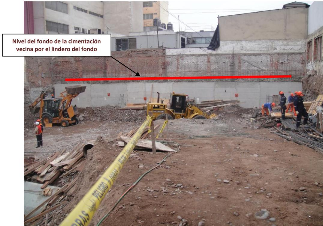
**FOTO 16: Nótese al fondo el perfil de cimentación de edificaciones de 2 pisos colindante por el fondo. No se observan columnas. (Primera Hilada de Muros Anclados)**
