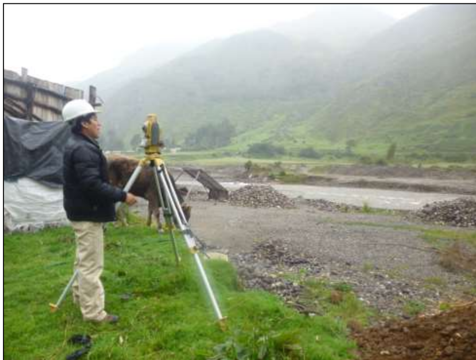
Foto N° 06: Se muestra el levantamiento topográfico de la cantera Badopampa (02/02/2016)
