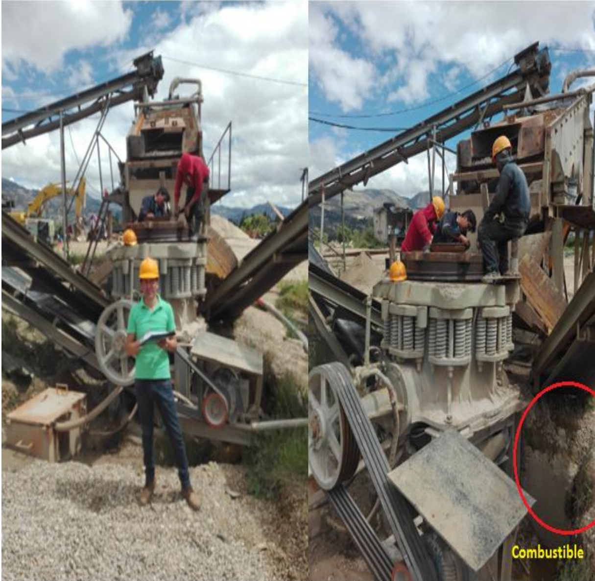
Figura 44. Chancadora de agregados -Tesisista margen derecha. Fuente: Elaboración propia, 2017.
