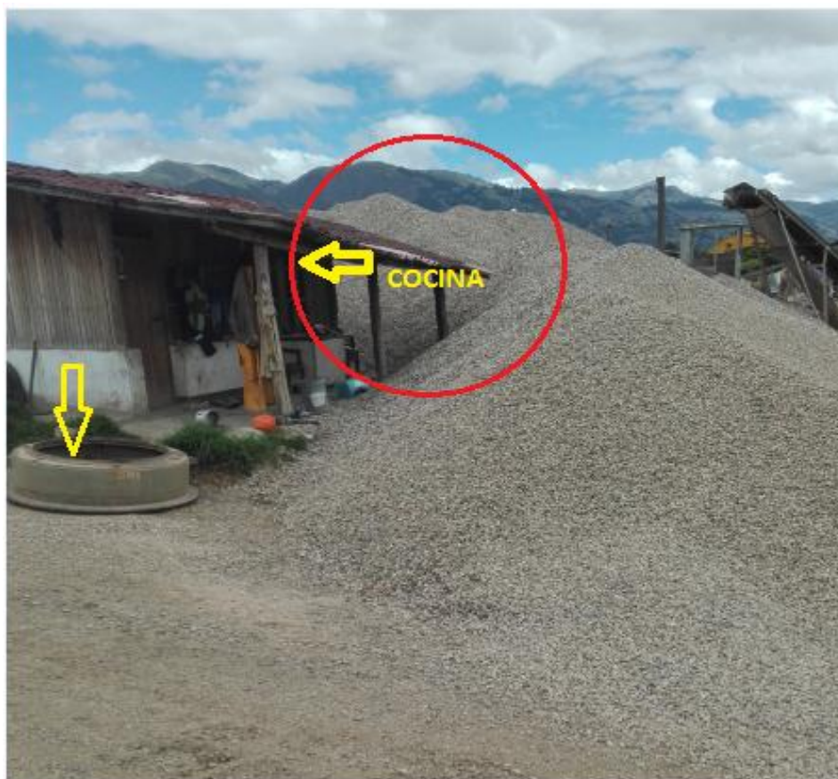
Figura 31. Identificación de Impactos en la vivienda de la cantera La Colpa I, 2017.
