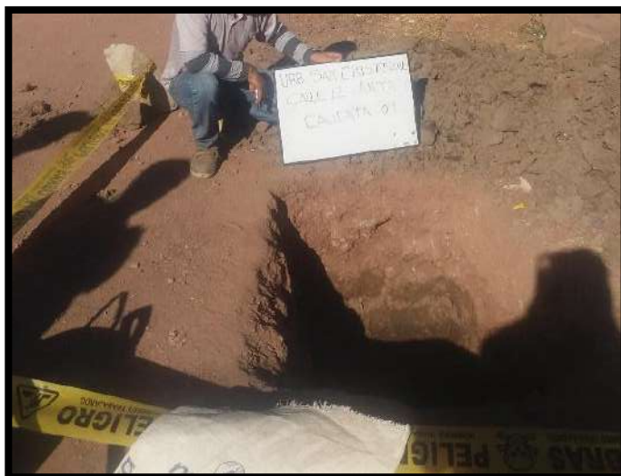
Figura 48.- Excavación calicata n° 03 en la calle 8 tramos 2-3
