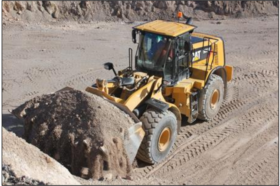
Figura 7: Retroexcavadora de la empresa S.M.R.L. Divina Revelación trabajando en acarreo de desmonte.
