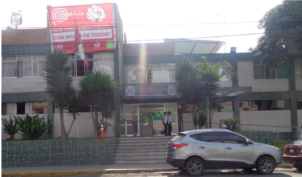
COMISARIA DE BARRANCO - AVENIDA SAN MARTIN S/N
