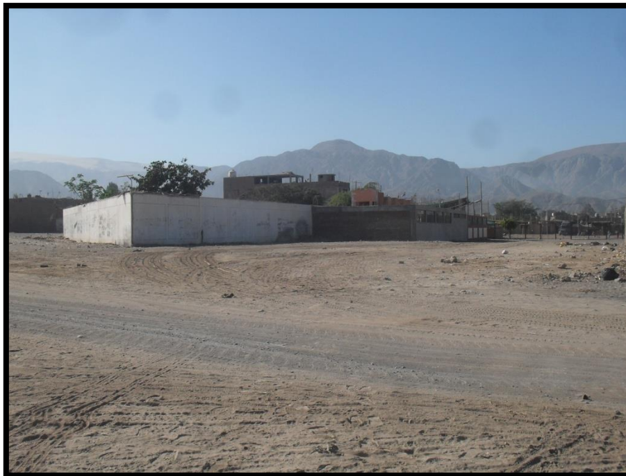
Foto N°2: Se observa en la fotografía el terreno donde se ubicara el Centro de Convenciones, vista de la parte trasera del INABIF.
