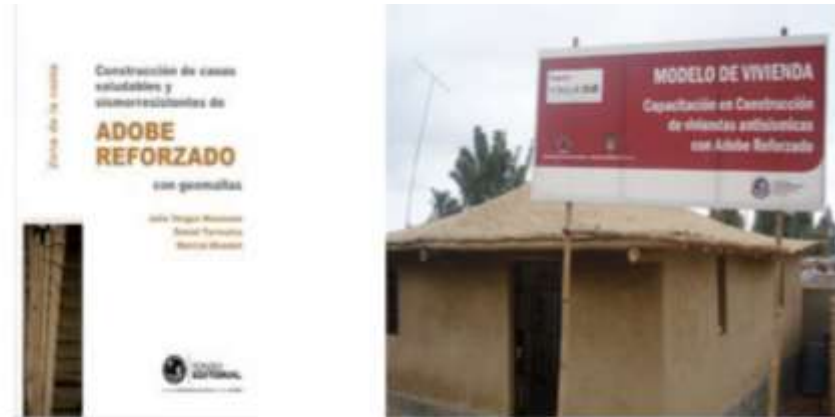
Figura N° 04: Viviendas construidas con adobe reforzado
