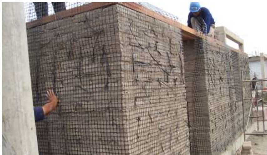
Figura N° 11: Muros de módulos terminados
