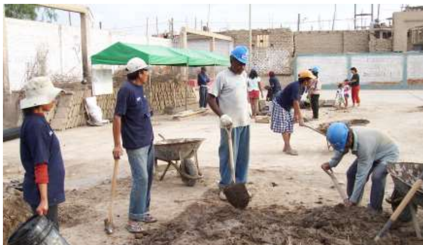
Figura N° 08: Preparación del mortero de adobe
