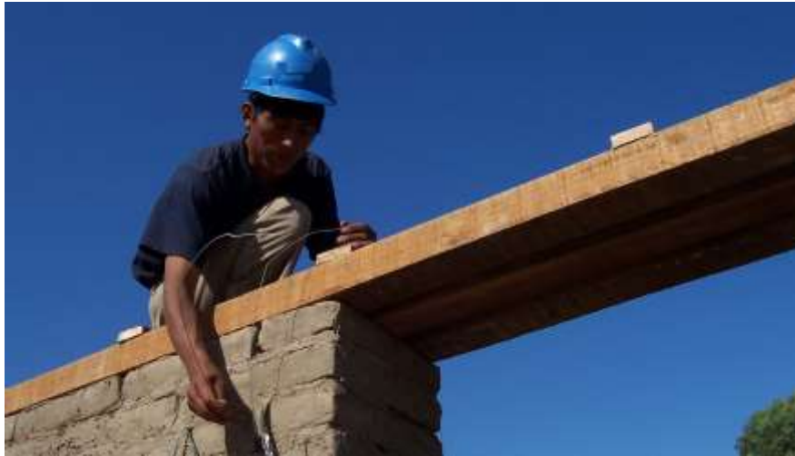
Figura N° 10: Asentado de adobes y lintel de caña
