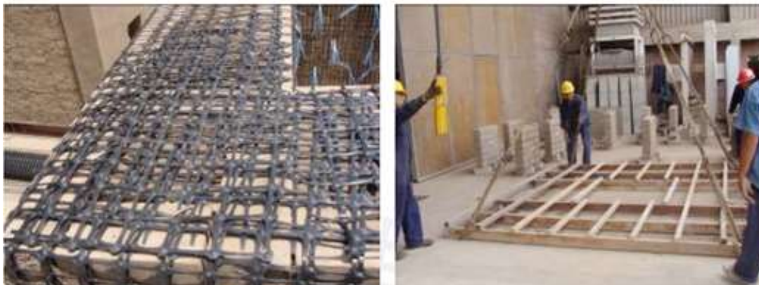
Figura N° 13: Fijación de la geomalla sobre la viga collar
