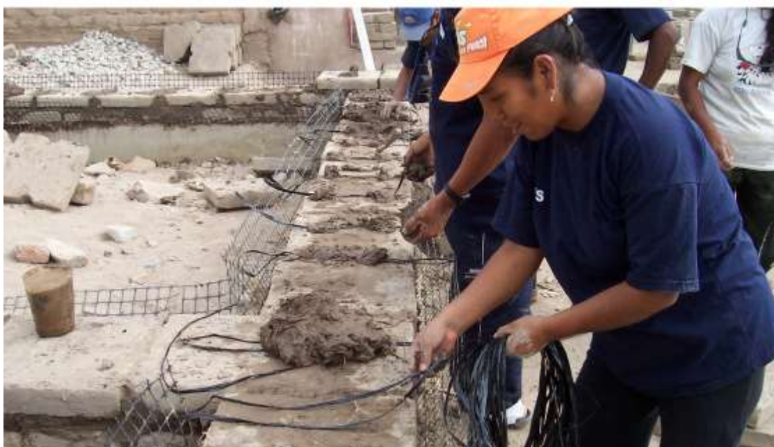
Figura N° 09: Colocación de rafia
