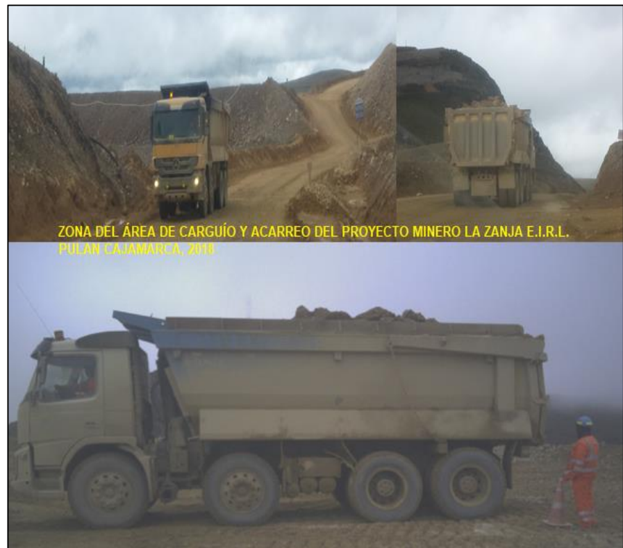
Figura 22. Zona del área de carguío y acarreo. La Zanja.
