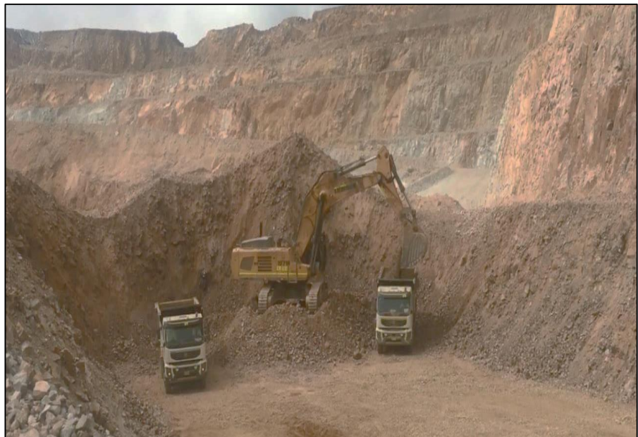
Figura 21. Equipos de acarreo - Proceso de retirar el material volado.
