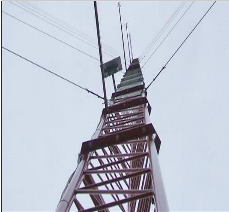
Figura 21: Torre auto soportada.
