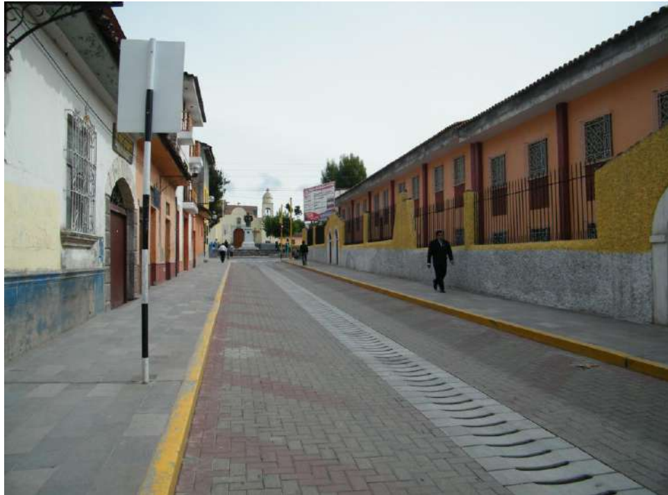
Imagen 01: Asilo de ancianos-parte exterior
