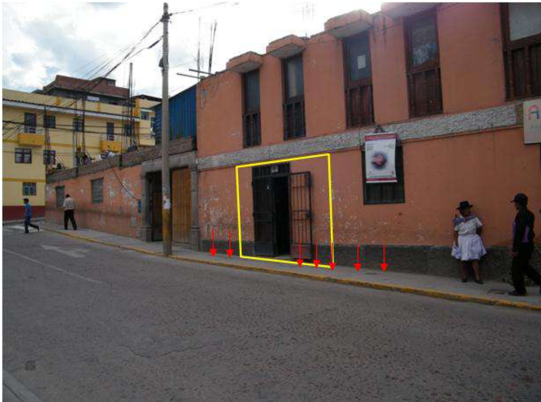
Imagen 04: Veredas exteriores usadas para descanso por los ancianos mientras esperan atención, al no haber suficiente espacio al interior de las oficinas.
