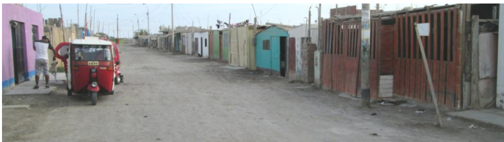
Ilustración N°03. Muestra el inadecuado sistema de accesibilidad peatonal, debido a la inexistencia de una delimitación clara entre la zona de circulación peatonal y vehicular. Fuente: Fuente Propia.
