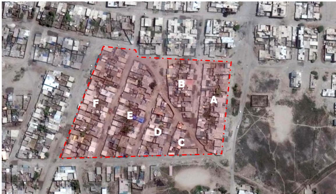
Ilustración N°70. Vista Satelital de las Manzanas a Intervenir que presentan vivienda precarias. Fuente: Google Earth/Elaboración Propia
