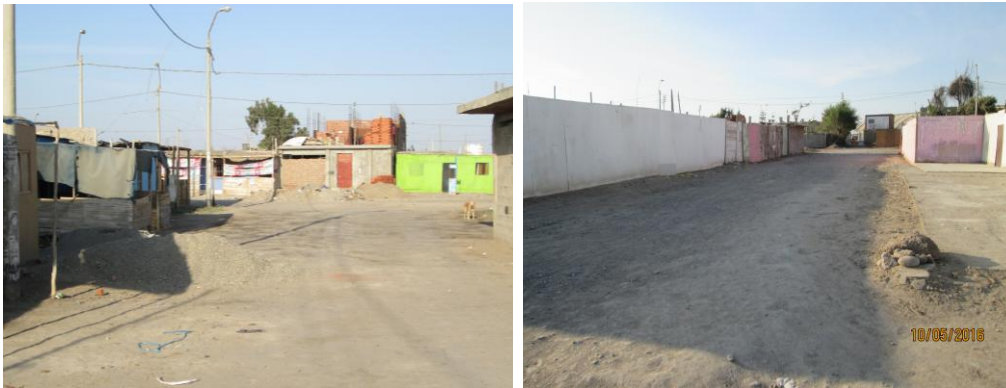
Ilustración N°05. Se observa en la Imagen izquierda, accesos vehiculares y peatonales no se cuentan definidos y presentan deficiente Delimitación de los Accesos Vehiculares. Ilustración N°06. Se observa en la Imagen Derecha, inexistencia de un tratamiento, delimitación o acondicionamiento de los accesos peatonales y vehiculares. Fuente: Fuente Propia.
