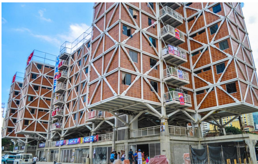
Ilustración N°35 , Sistema Constructivo empleado, Estructuras de Acero y Losa Colaborante. Fuente: Plataforma Arquitectura, Archdaily.
