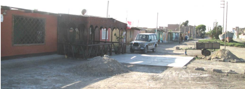
Ilustración N°04. Se observa que los accesos peatonales se encuentran desarticulados, si bien algunas zonas presentan aceras, no existe una continuidad o comunicación lo que ocasiona desorientación al peatón que transita o camina por la zona. Fuente: Fuente Propia.
