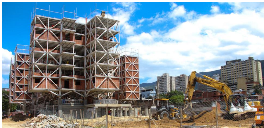
Ilustración N°33, Construcción del Complejo Arquitectónico y Urbanístico Santa Rosa.
