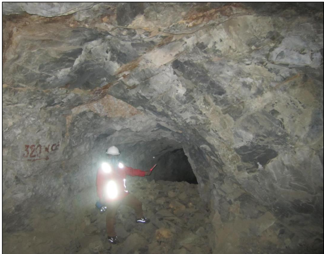
Figura 6: Caída de rocas en la Mina Paredones.
