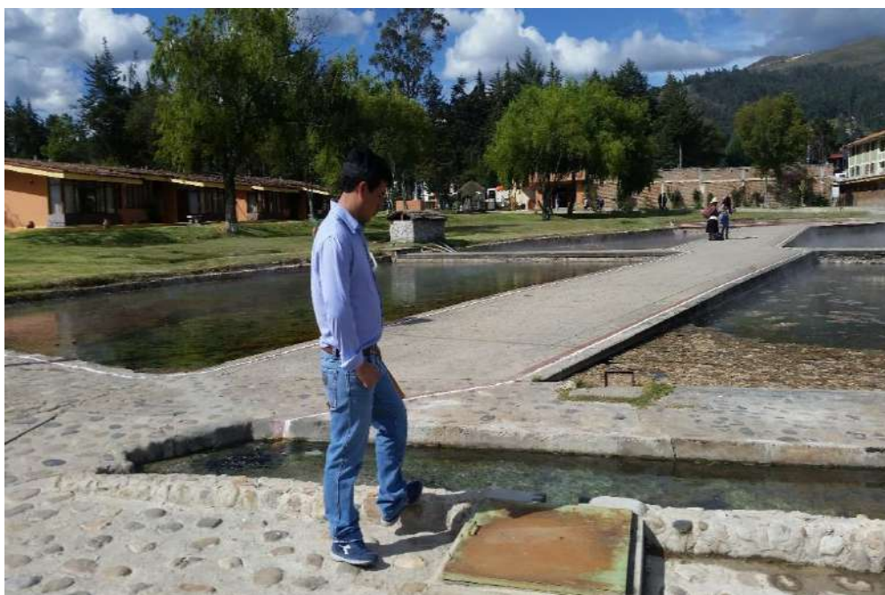
Figura 6: Captación de agua para llenar el vaso de la piscina semi olímpica
