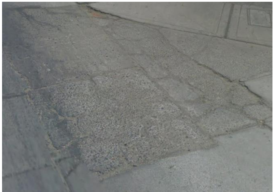
FOTOGRAFÍA 10, LOSA SUBDIVIDIDA – JIRON AREQUIPA CUADRA TRES
