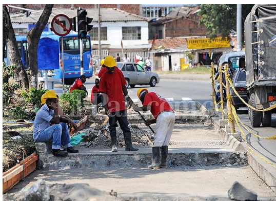
Imagen 28: Remoción de partes afectadas de concreto
