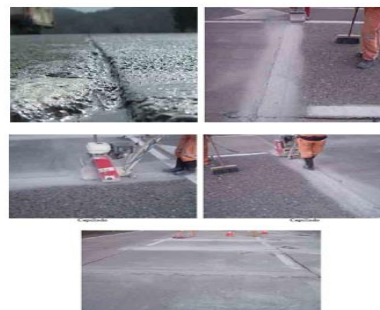
Imagen 22: Cepillado de juntas – Fuente (Deterioros en pavimentos flexibles y rígidos)- Ricardo Javier Miranda Rebolledo Valdivia – Chile - 2010
