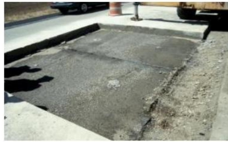
Preparación de la superficie
