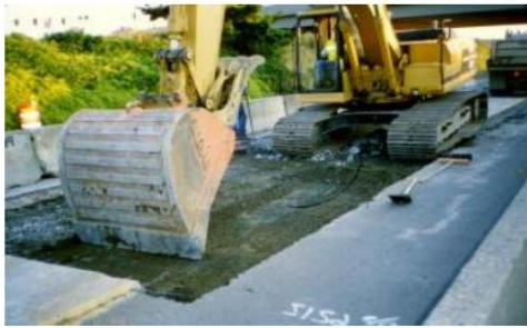
Remoción material deteriorado
