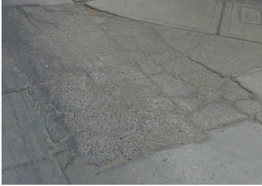
FOTOGRAFÍA 13, LOSA SUBDIVIDIDA – JIRON AREQUIPA CUADRA TRES
