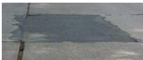
Imagen 20- limpieza y resellado de juntas- Fuente (Deterioros en pavimentos flexibles y
