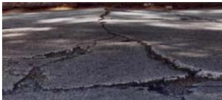
Imagen 17: Levantamiento de losas- Fuente: Ing. Luis F. Altamirano Kauffmann 2007
