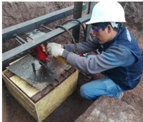
Figura 31: Montaje del equipo sobre el bloque moldeado in si-tu.
