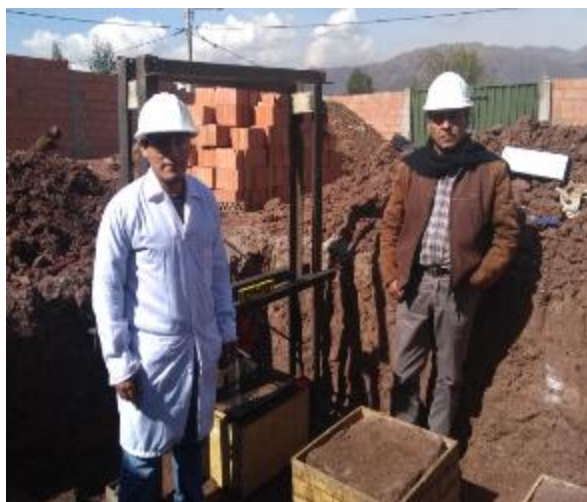
Fotografía N° 18: Verificación de los ensayos in situ.
