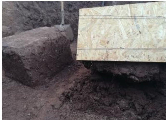
Figura 34: Superficie de falla debido al esfuerzo cortante.
