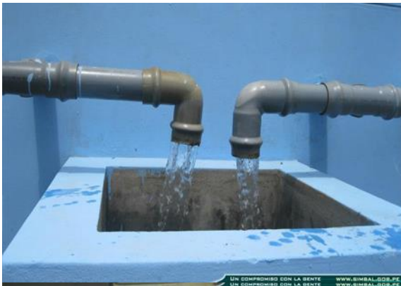
Foto 08: Planta de Tratamiento Simbal. Autor: Municipalidad Distrital de Simbal.
