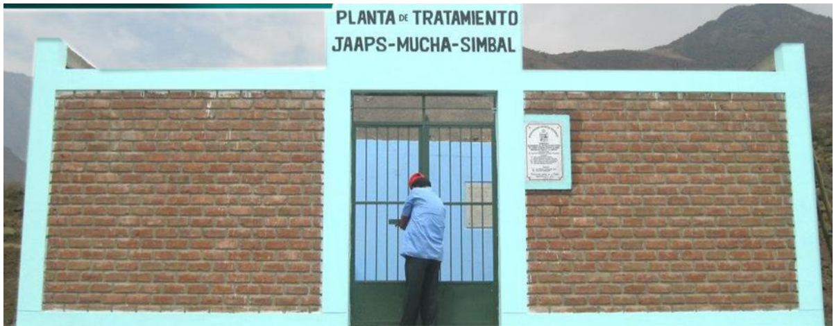
Foto 07: Planta de Tratamiento Simbal. Autor: Municipalidad Distrital de Simbal.
