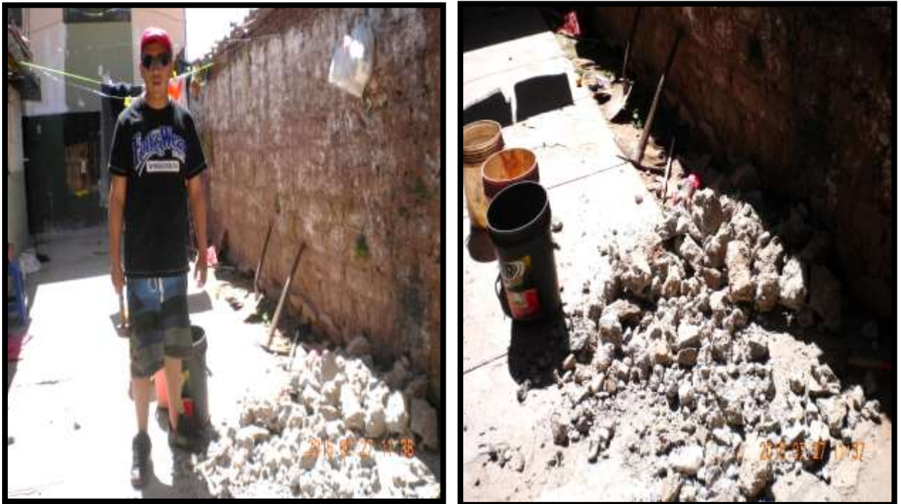
Figura 26 trituración manual del agregado reciclado
