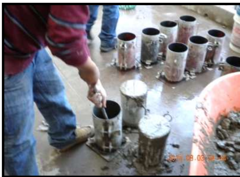
Figura 32 Preparacion de Testigos de Concreto
