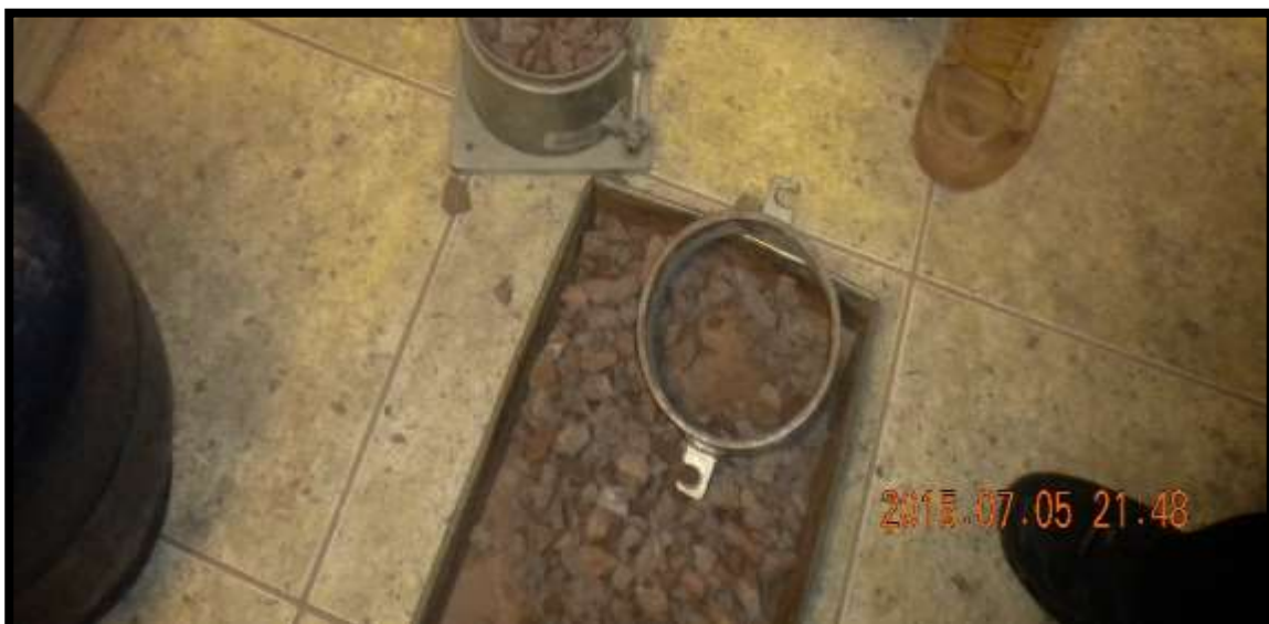
Figura 22 Chuseado de Material Grueso para eliminar los vacios existentes
