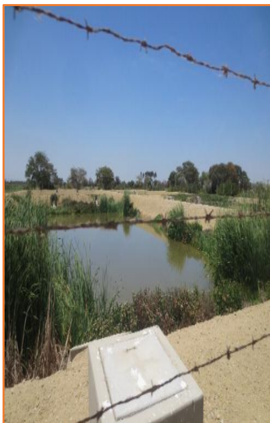
Laguna de Oxidación de la Municipalidad Distrital de Bellavista de la Unión
