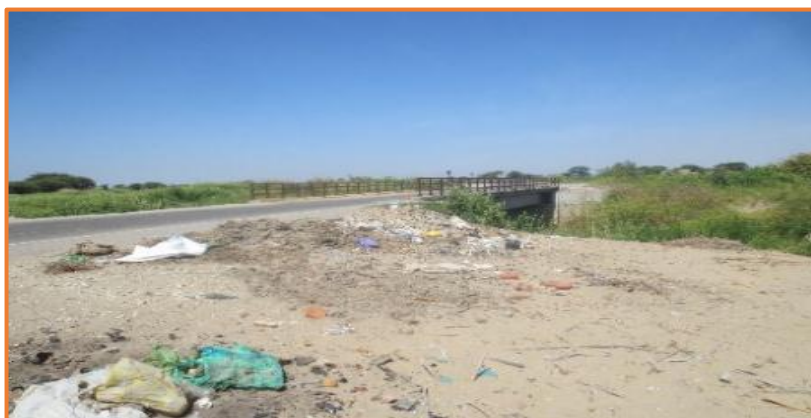
Disposición inadecuada de residuos sólidos de la Municipalidad Distrital de Rinconada Llicuar
