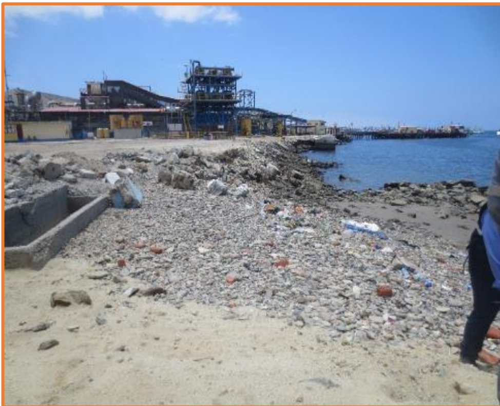
Vista lateral de la disposición inadecuada de residuos sólidos CORPORACIÓN PESQUERA INCA. S.A.C
