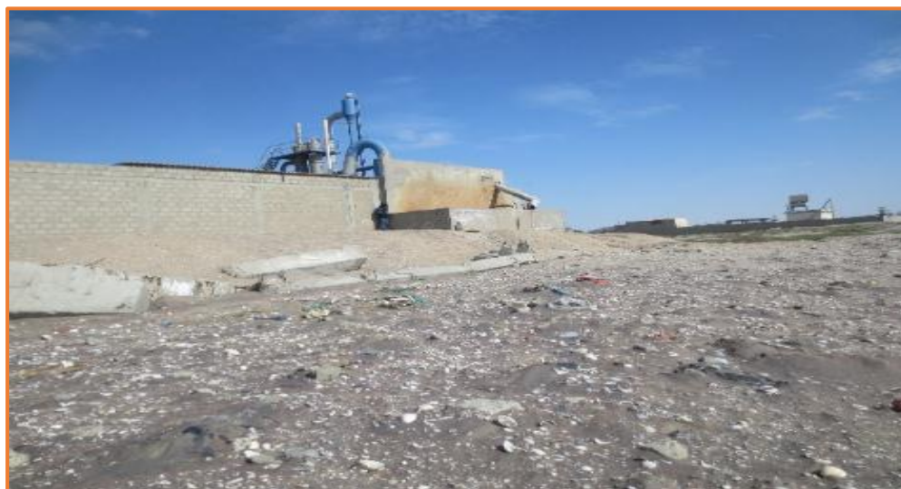
Disposición inadecuada de residuos sólidos parte posterior AGROFISHING Y DERIVADOS S.A.C.
