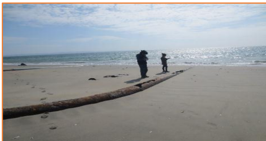
Disposición Inadecuada de tuberías de 20 pulgadas de diámetro., dirección Bahía de Sechura
