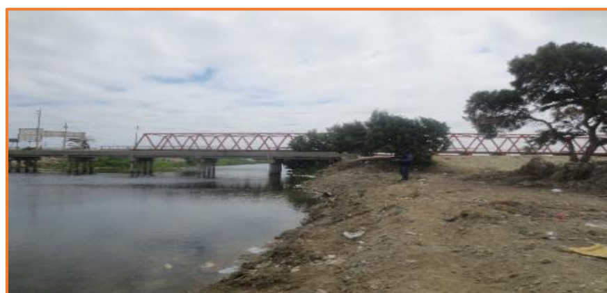
Disposición inadecuada de residuos sólidos por debajo del puente del Dren de Sechura
