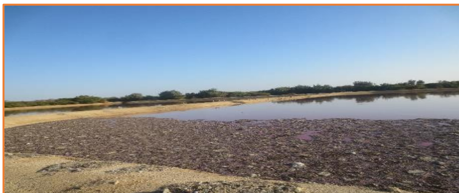
Presencia de natas en la Laguna de Oxidación de la Municipalidad Provincial de Sechura
