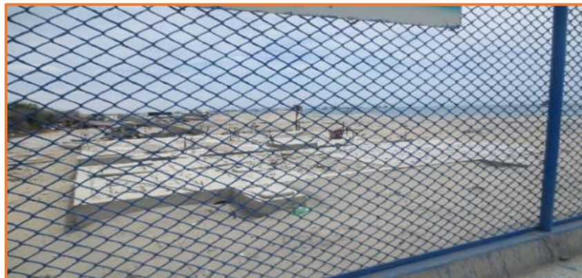
Pozo colector de agua de limpieza del Desembarcadero Multipropósito JUAN PABLO S.A.C.
