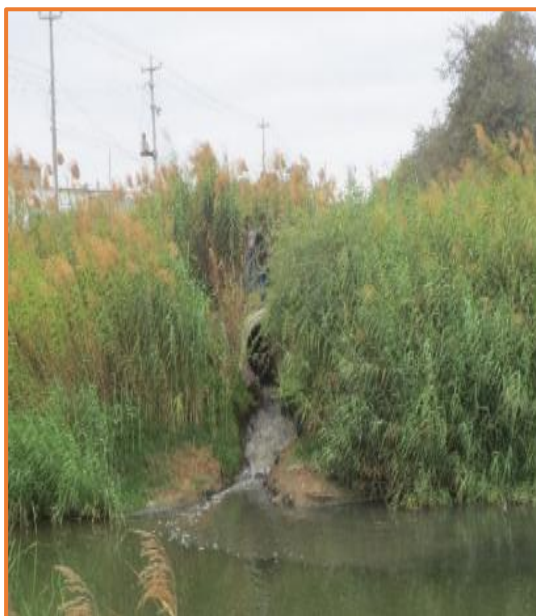
Descarga de agua residual doméstica de la Municipalidad Distrital de la Unión a una canal tajo abierto secundario que desemboca en el Dren Sechura
