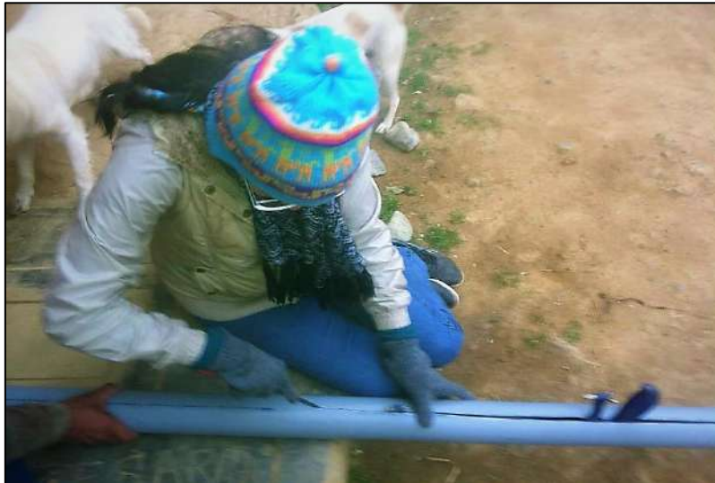
Fotografía N° 06: Corte del tubo de PVC para la confección de la canaleta o colector de agua
