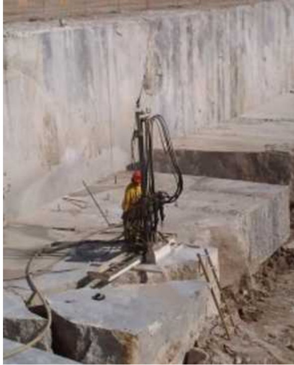
Figura 3: Perforación de barrenos próximos. Fuente: Trigueros (2013).
