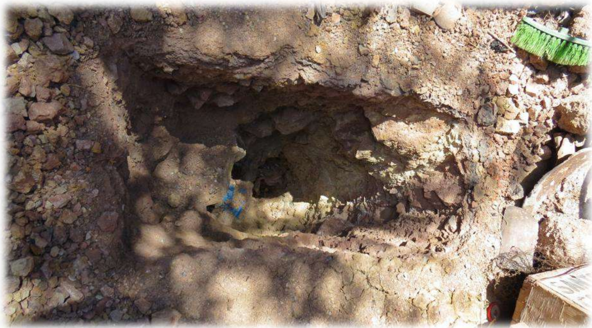
Figura 55 Vista de Calicata a pozo abierto
