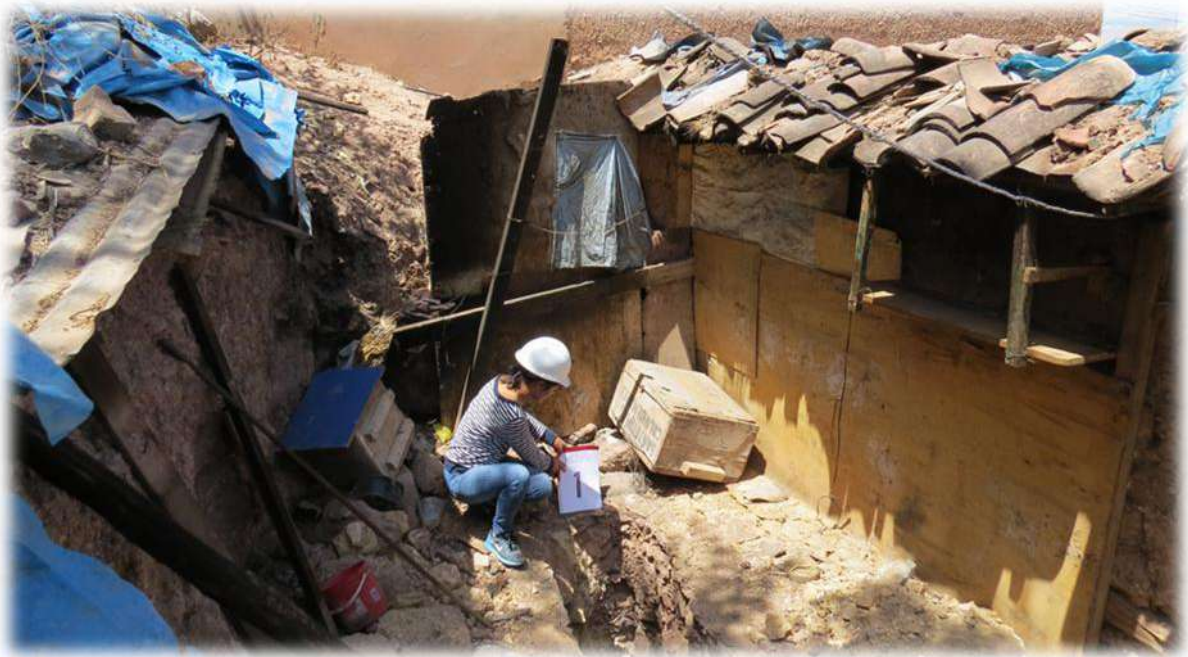
Figura 56 Excavación de la calicata N° 01
