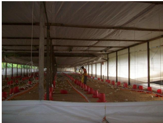
Figura 9: Ampliaciones del galpón
