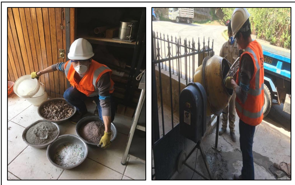
PROCESO DE MEZCLADO DE MATERIALES
