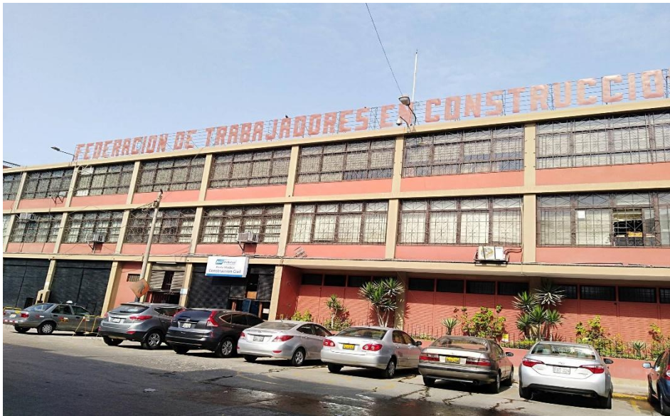
FOTO N° 01: Exteriores de la Posta Medica Construcción civil
