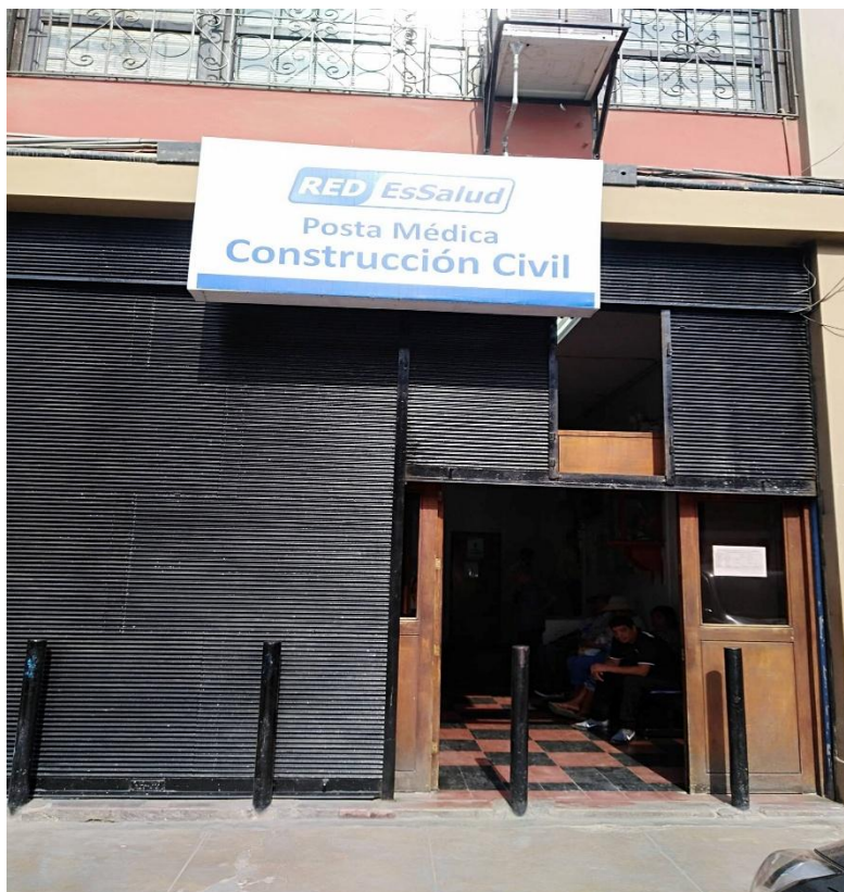
FOTO N° 02: Puerta principal de la Posta Medica Construcción civil
