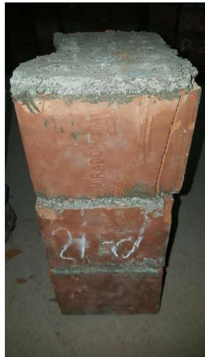
Presenta falla vertical.
