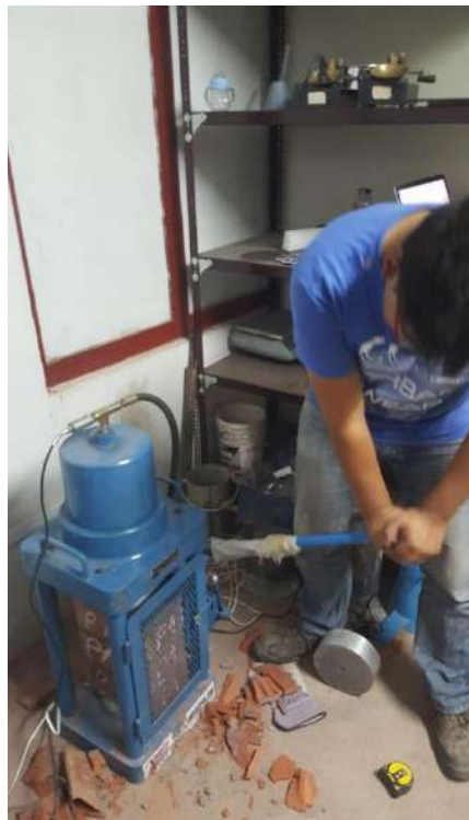
Presenta falla vertical.
