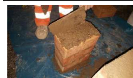
Foto 4.2.7.2.3. Ultima base de mortero
