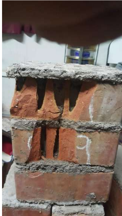
Presenta falla explosiva.
