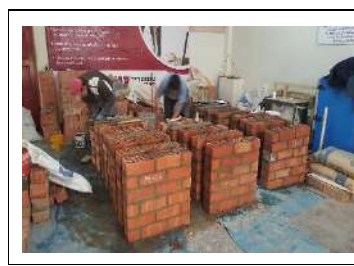
Foto 4.1.2. Vista general de los 27 muretes.
