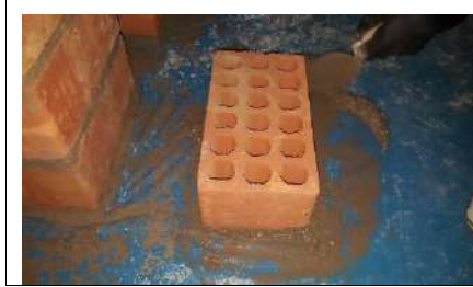
Foto 4.2.7.2.2. Inclusión de mortero a toda la superficie de asiento.
