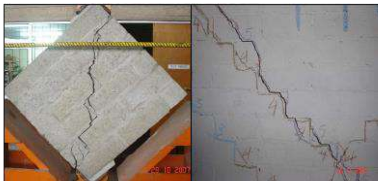
Fig.10.1.- Fisuras patrón en muros con ladrillos de concreto
