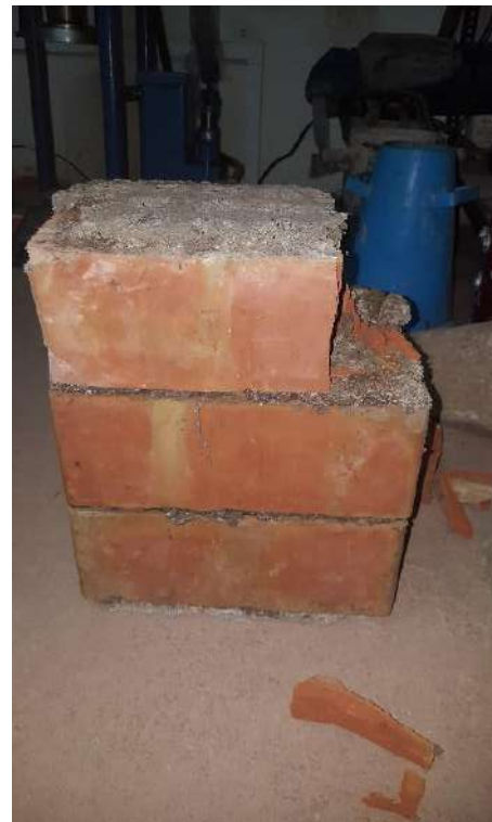
Presenta Falla de aplastamiento la parte superior.
