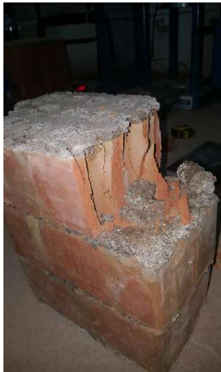
Presenta Falla de aplastamiento la parte superior.
