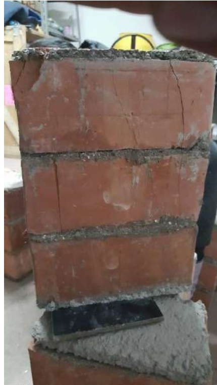
Presenta falla vertical y falla de aplastamiento.
