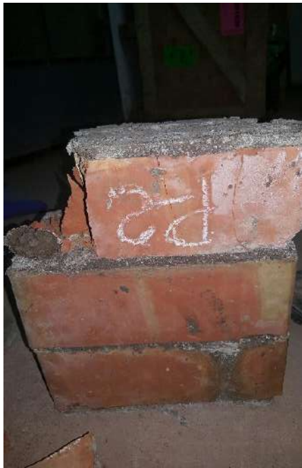
Presenta Falla vertical y Falla de aplastamiento la parte superior.
