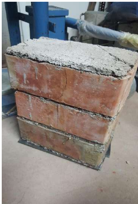
Presenta falla vertical.
