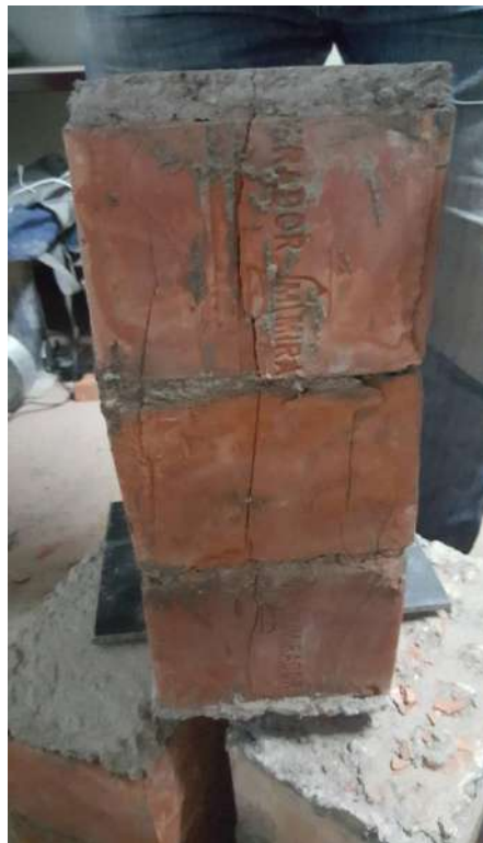
Presenta falla vertical.
