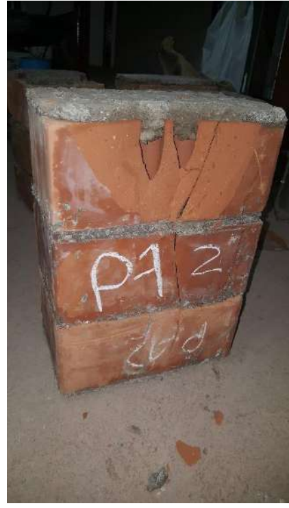
Presenta falla vertical y falla de aplastamiento.
