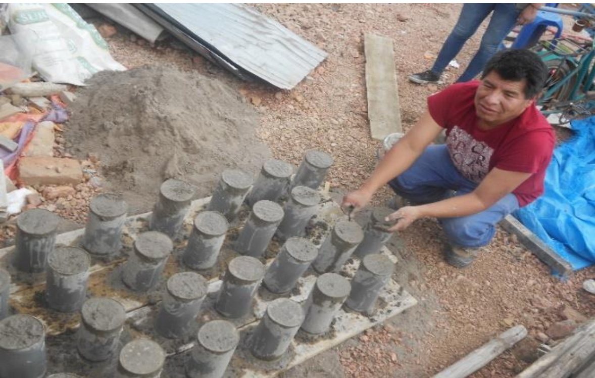
Fotografía 8-6 Llenado de Concreto en los Cilindros de 4"x8"
