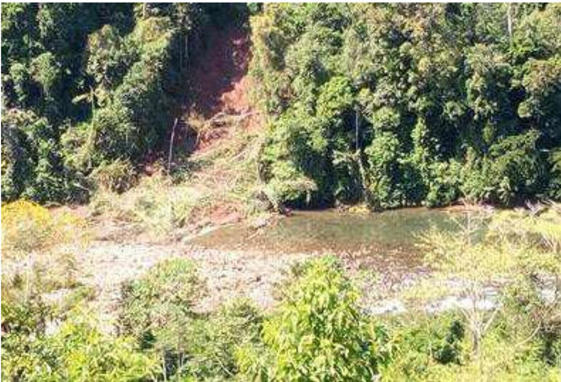
**Figura 240.** Deslizamientos en la progresiva 11+268.5 pese a tener una pendiente moderada que no alcanza el 45%.
