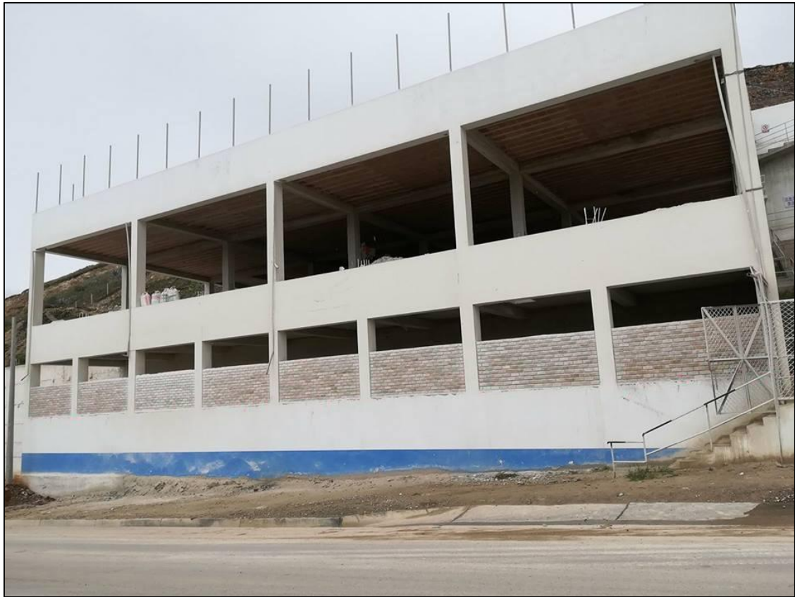
Figura 41: Infraestructura de la calera.
