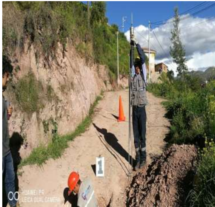
Calicata (C-2) TAMBOBAMBA BAJA.
