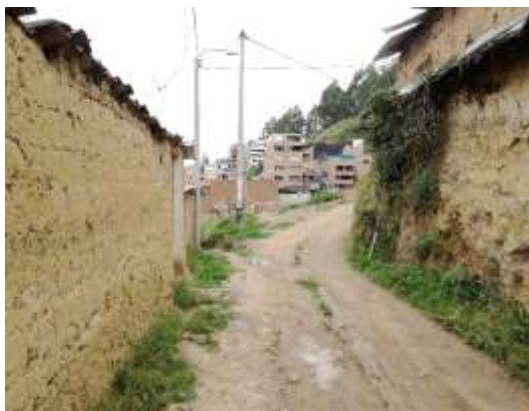
Figura 18 Tramo 1 - Tambobamba Baja
