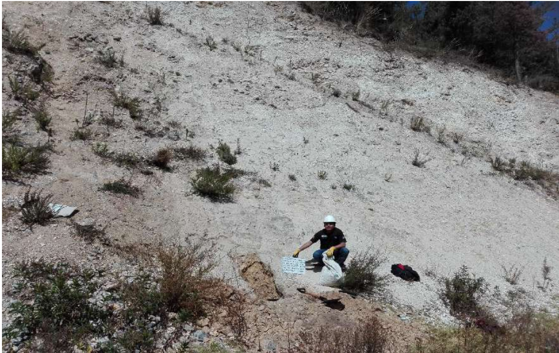
Fotografía Nª 4: Vista de la calicata C-1 extracción de muestra de suelos
