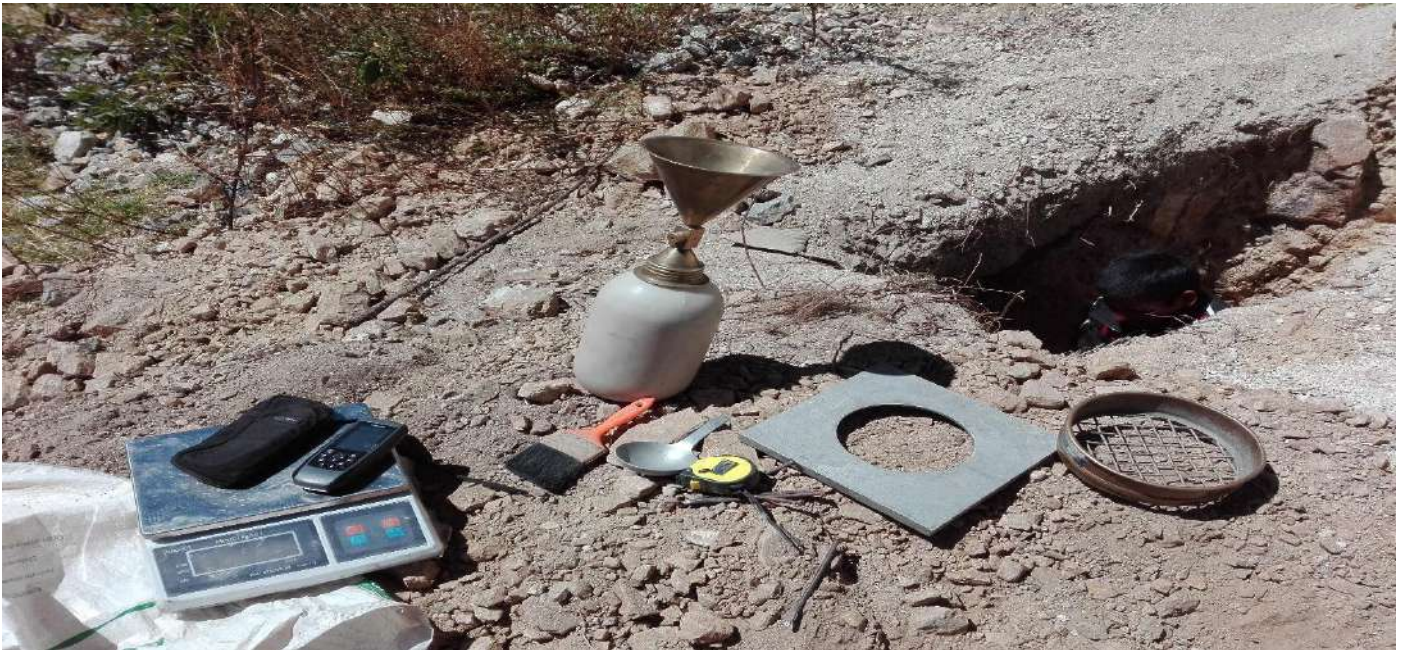
Fotografía Nª 22: Vista del ensayo de densidad de campo
