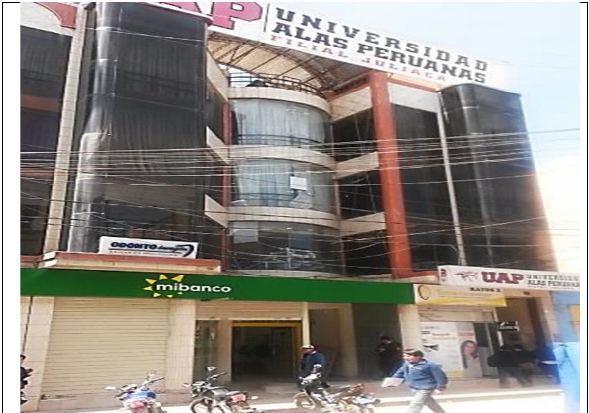
Foto N° 01: Imagen donde se muestra las ventanas con los vidrios primarios de la edificación universitaria en regular estado de conservación.
