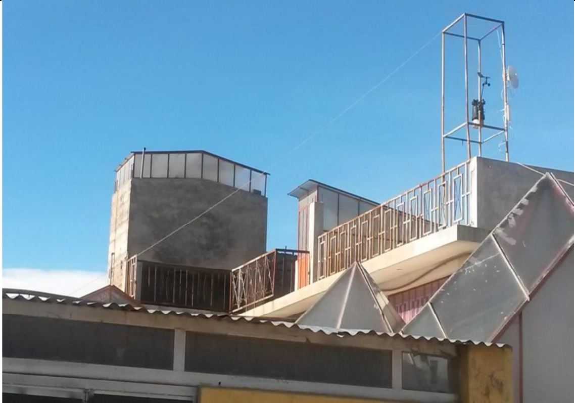
Foto N° 03: Imagen donde se muestra el tanque cisterna.
