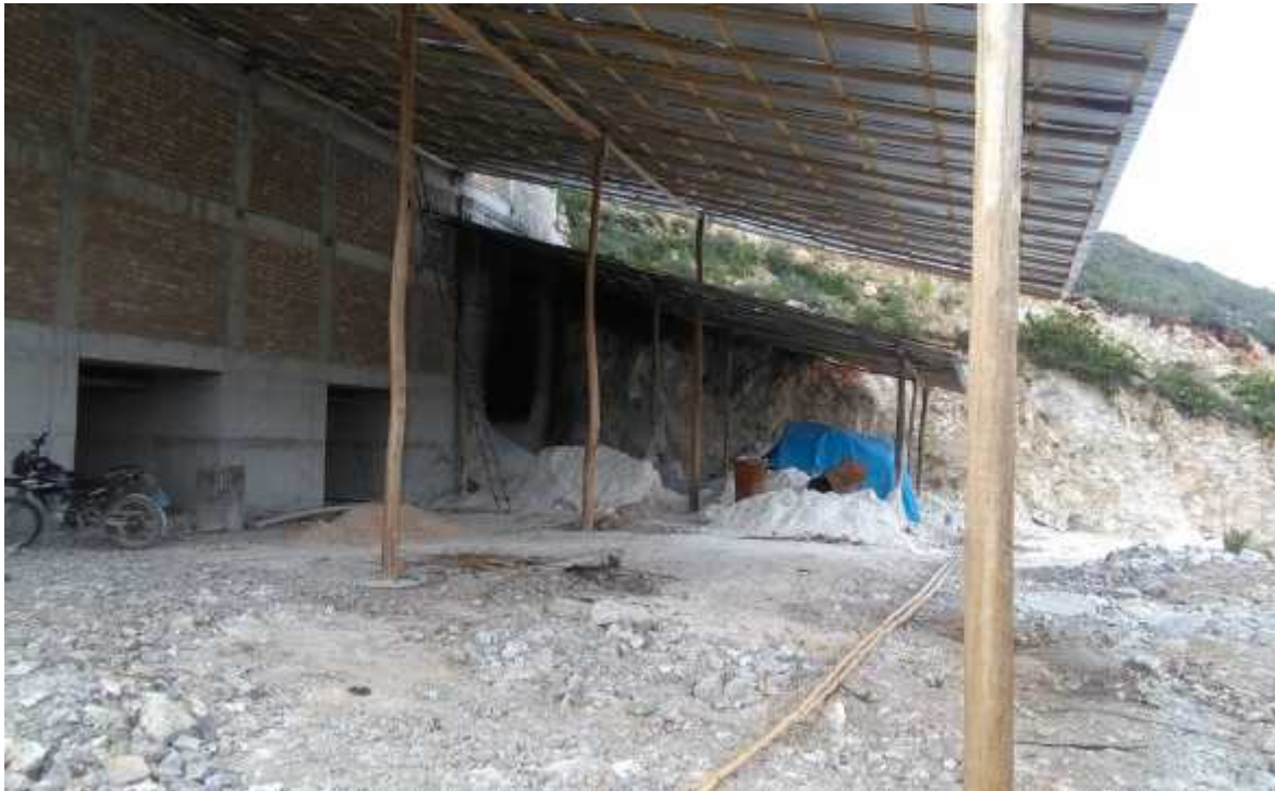
Figura 27: Zonas de descarga de cal - Calera Berly.
