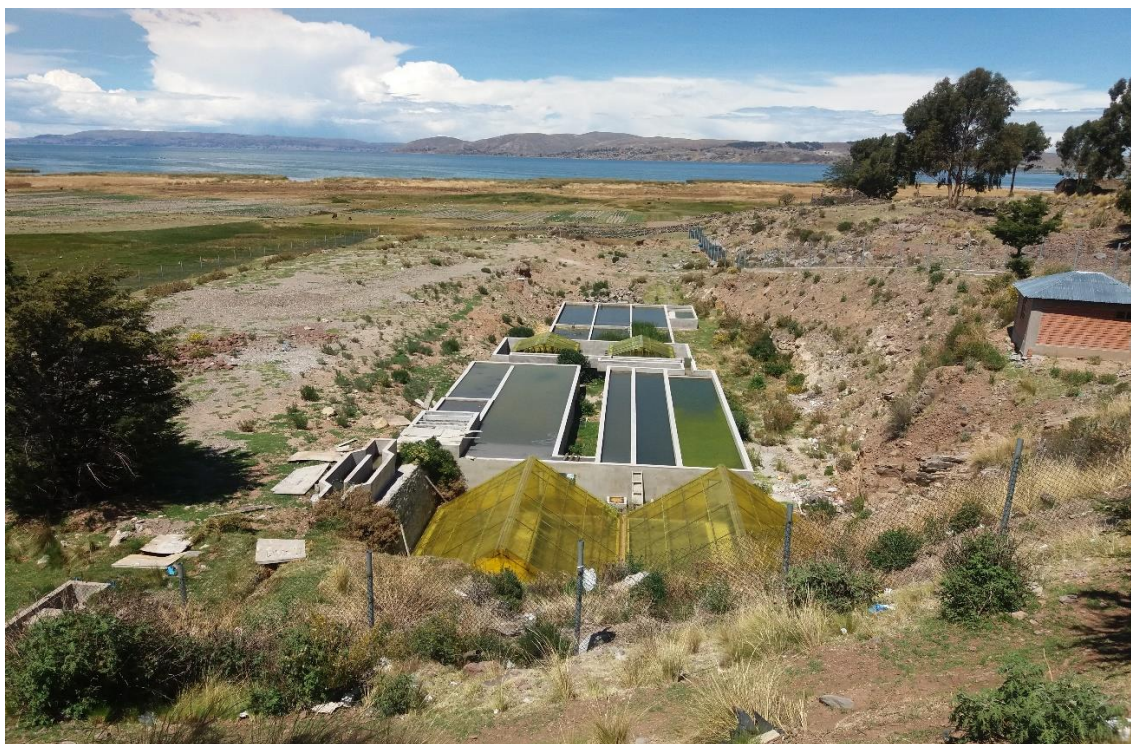
Foto 3: Planta de tratamiento de aguas residuales 1 – Norte
