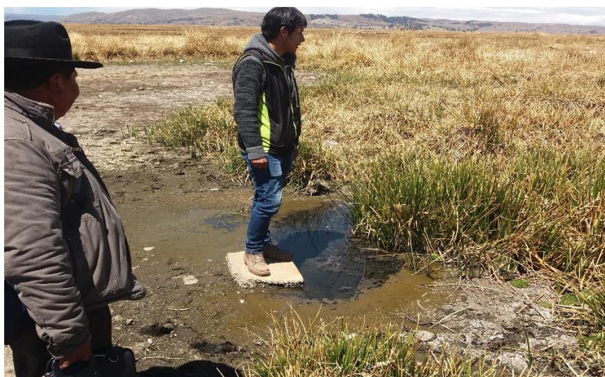
Figura 14 Emisor obstruido por falta de mantenimiento
