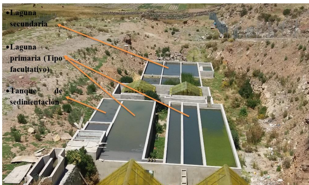
Figura 9 Planta de tratamiento Norte - PTAR 1
