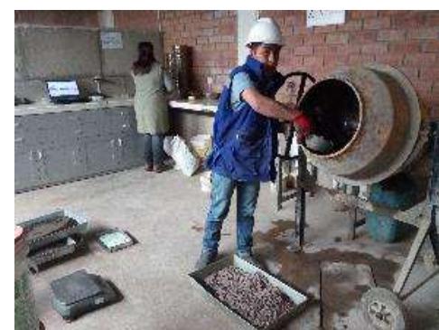
Vertiendo los materiales al trompo
