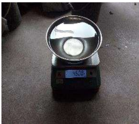
Pesando el agua para la mezcla de concreto
