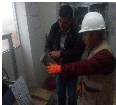
Analizando el tipo de falla
