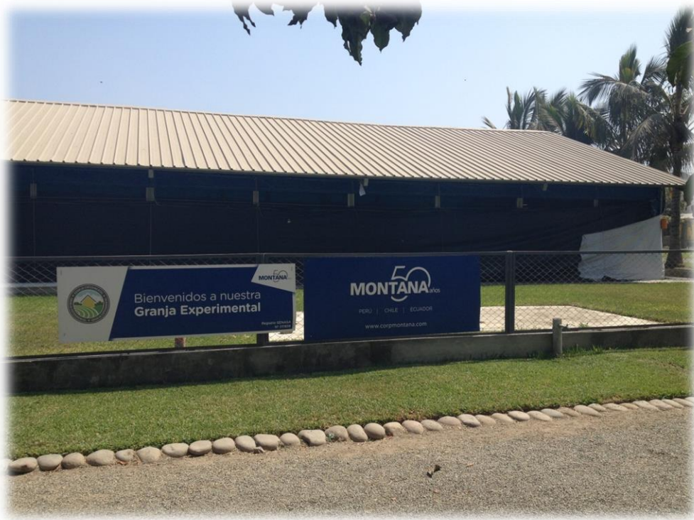
Figura 2. Instalación exterior de la granja experimental Montana
