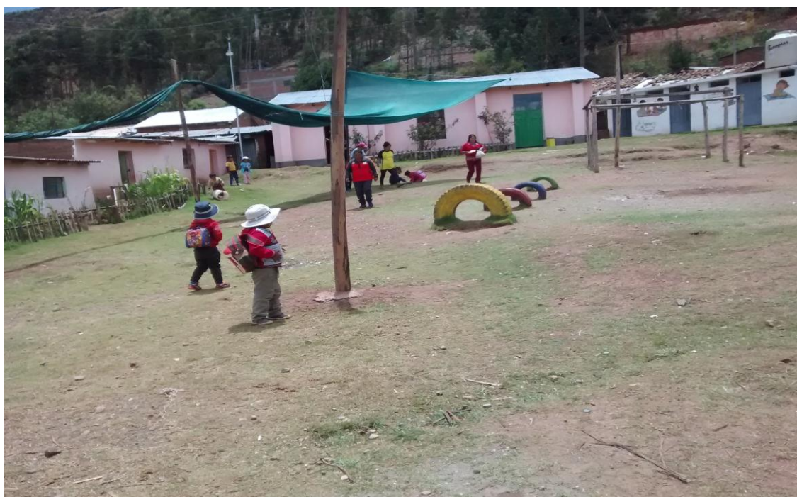
Figura N° 2. Instalaciones de la Institución Educativa Inicial N° 344 / Mx-P “Taca”.
