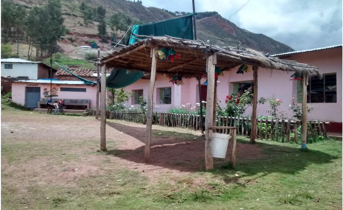
Figura N° 3. Instalaciones de la Institución Educativa Inicial N° 344 / Mx-P "Taca".
