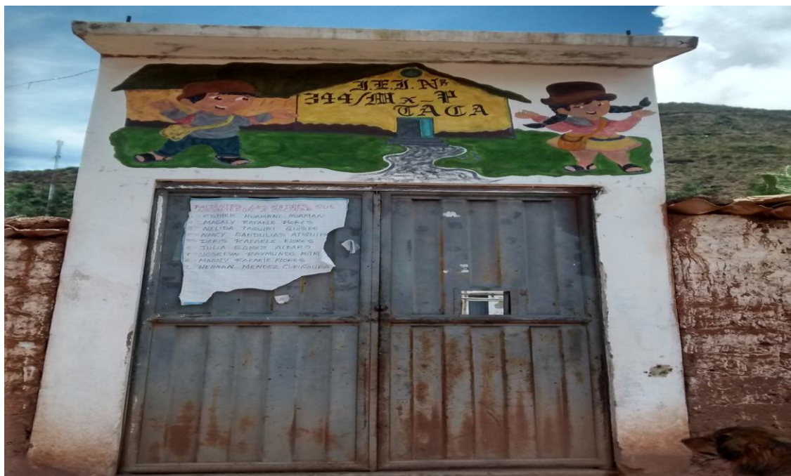
Figura N° 1. Entrada principal de la Institución Educativa Inicial N° 344 / Mx-P “Taca”, distrito de Canaria, provincia de Víctor Fajardo, departamento de Ayacucho; donde se realizó la investigación.
