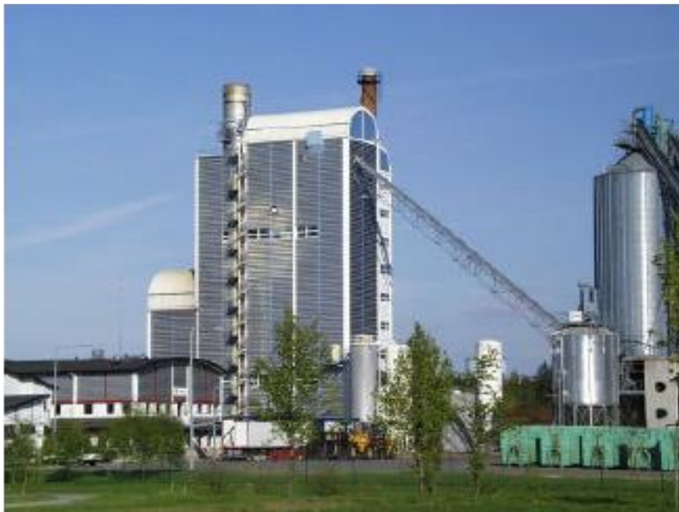
Figura N° 18: Planta de demostración BIGCC en Vamamo (Finlandia 7 MWe)
