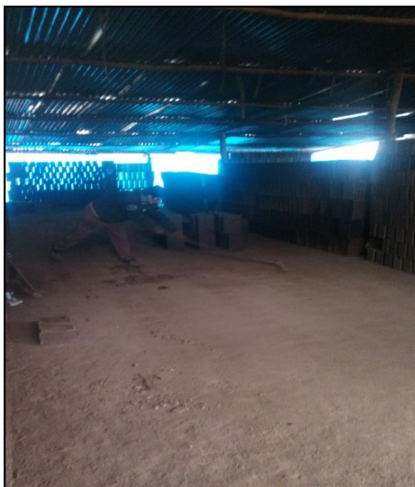
FIGURA 44. Preparado de la zona de secado de las unidades de albañilería King Kong de 18 huecos.
