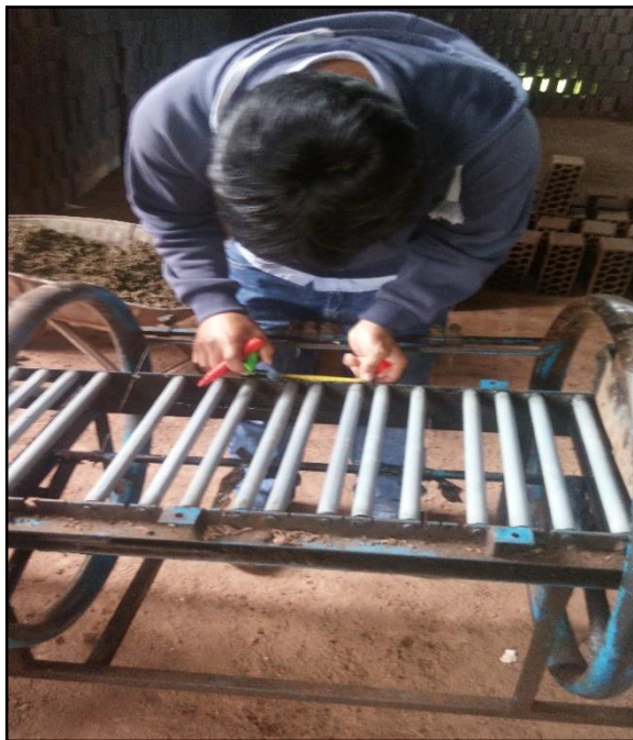
FIGURA 38. Verificación de las medidas de corte para los moldes de las unidades de albañilería King Kong de 18 huecos ( h= 9\text{cm} , L = 24\text{ cm} , a= 14\text{ cm} )
