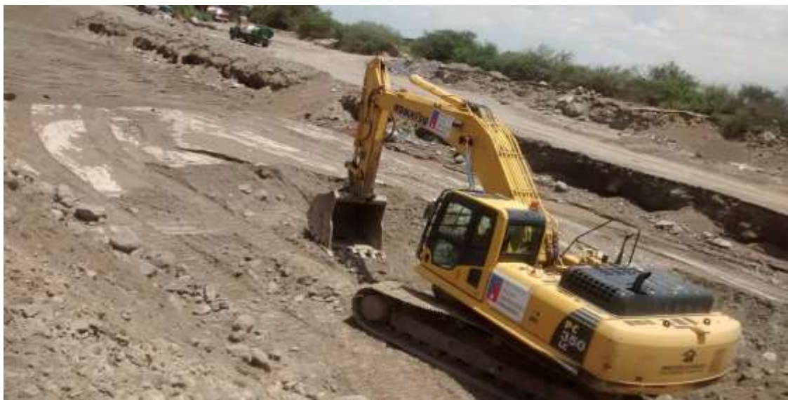
Descripción de Foto N° 11: Trabajos de descolmatación del cauce en el sector de Kansas del distrito de la Tinguña, por el Programa Ciudades Sostenibles del Ministerio de Vivienda Construcción y Saneamiento
