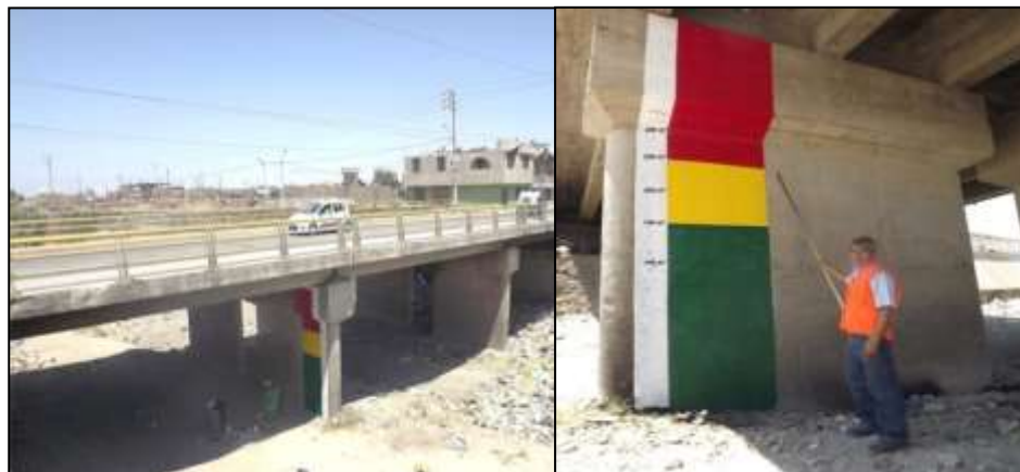
Figura 2.94: Pintado de los puentes con los umbrales para que la población pueda hacer seguimiento de los caudales de agua.
