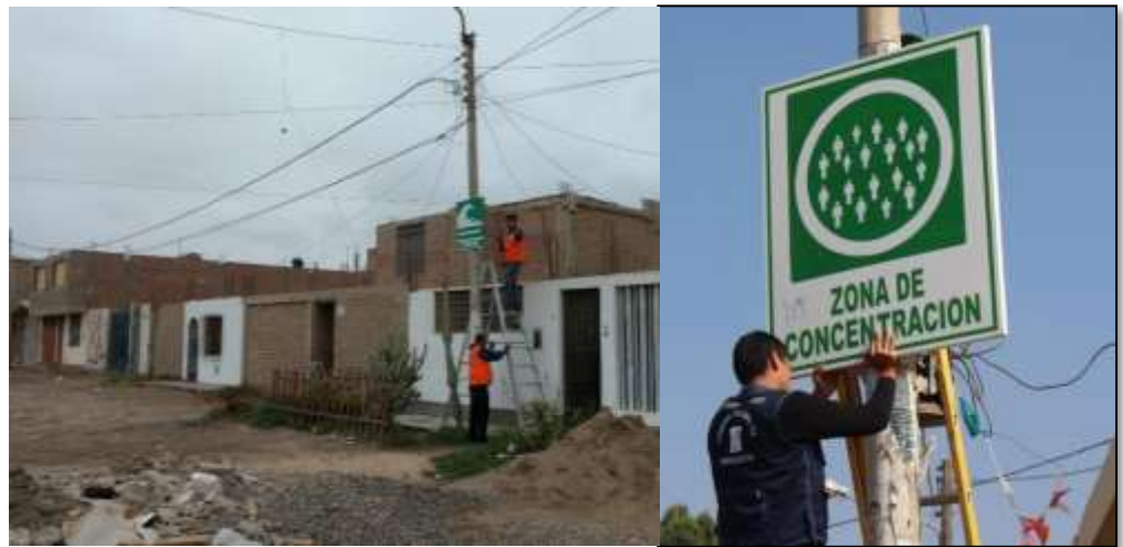
Figura 2.99: Instalación de señaléticas
