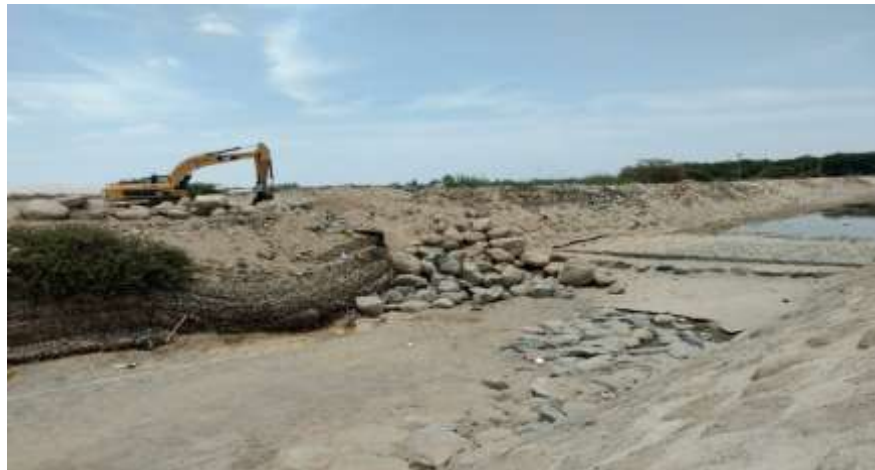
Figura 2.83: Enrocado del río.
