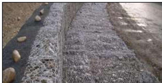
Figura 2.78: Estructura de gaviones (cajas rectangulares de acero).
