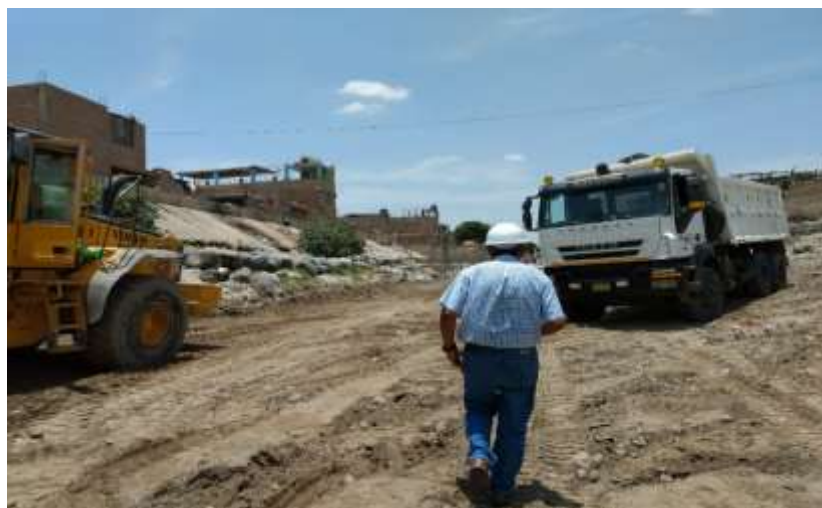
Figura 2.84 : Cauce del rio Ica, constituido por arena y limo.
