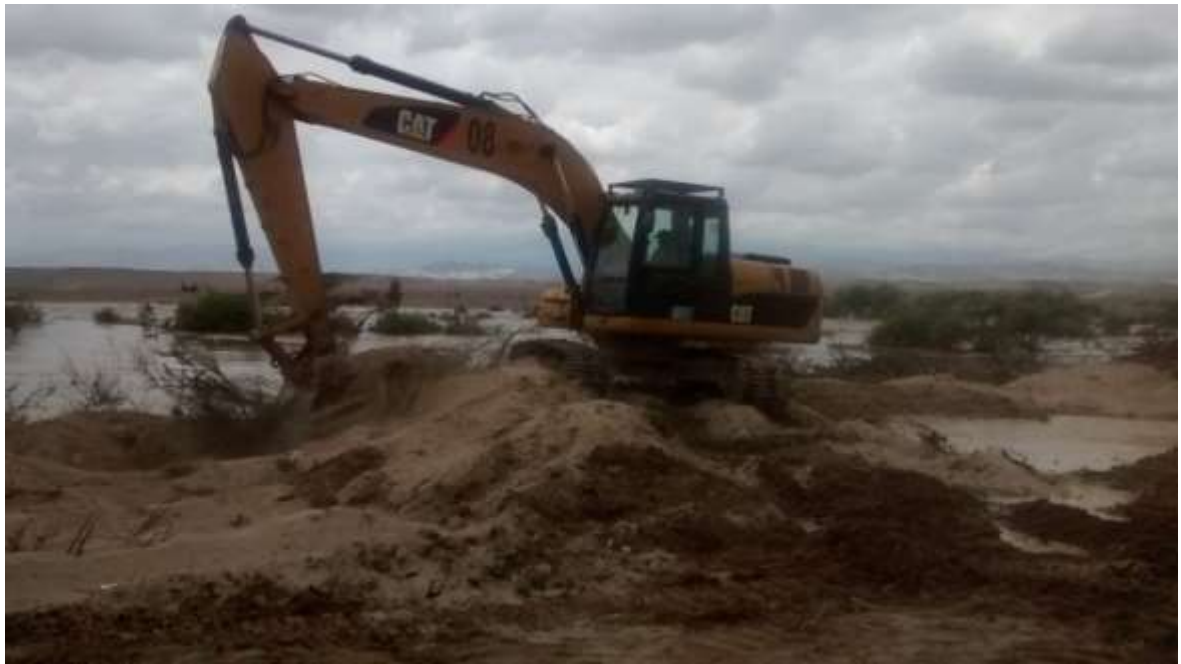
Descripción de Foto N° 10: Trabajos de Limpieza en la Carretera Panamericana Sur, por huaico ocurrido en el Km 336 (sector Ocucaje).
