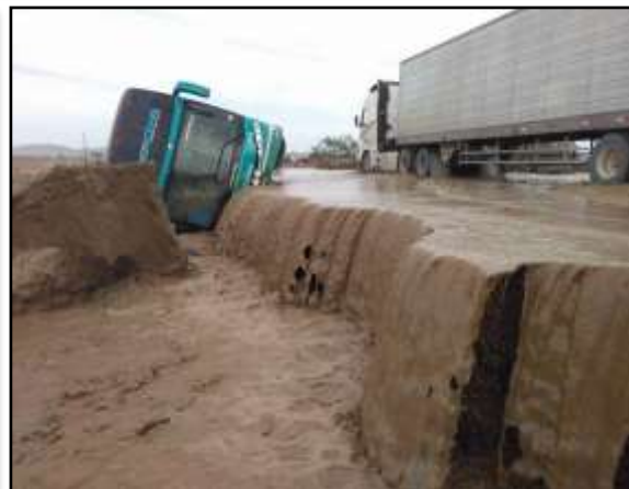
Descripción de Foto N° 15: Se aprecia el desprendimiento del pavimento en uno de sus carriles rumbo al sur, de la panamericano sur en Ica en el km 336, generado por la erosión del agua, producto del huaico.
