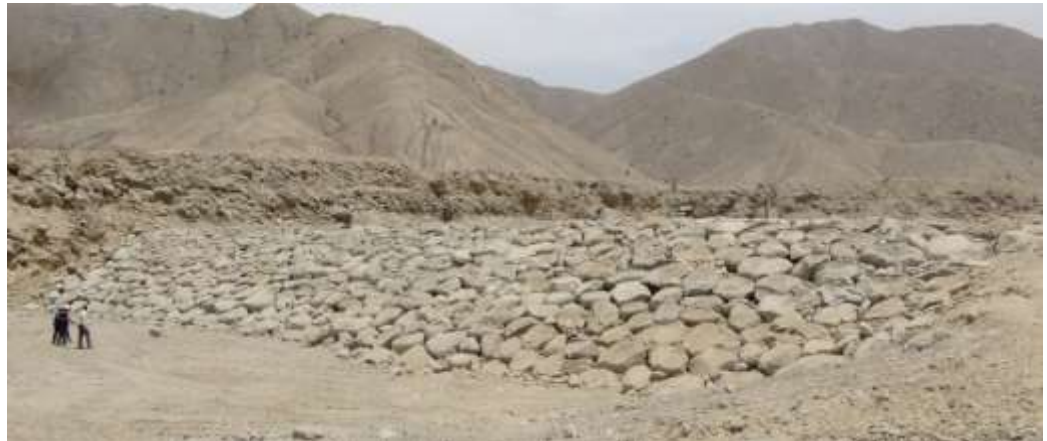
Figura 2.77: Fotografía de la protección con diques en la quebrada la Yesera.
