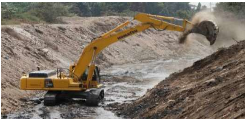
Figura 2.2: Trabajos de descolmatación en los cauces del río.
