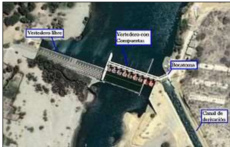
Figura 2.85: Canal de derivación
