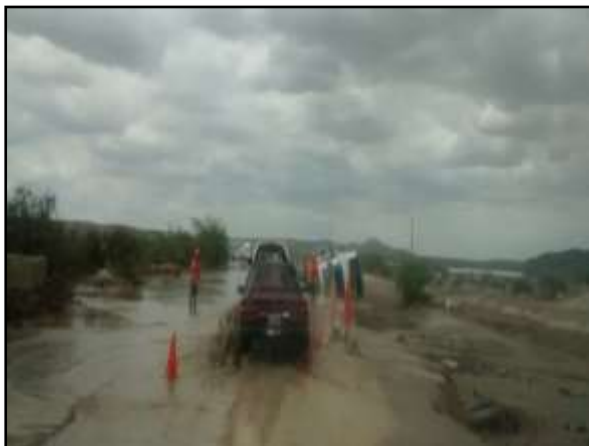
Descripción de Foto N° 15: Se aprecia el desprendimiento del pavimento en uno de sus carriles rumbo al sur, de la panamericano sur en Ica en el km 336, generado por la erosión del agua, producto del huaico.
