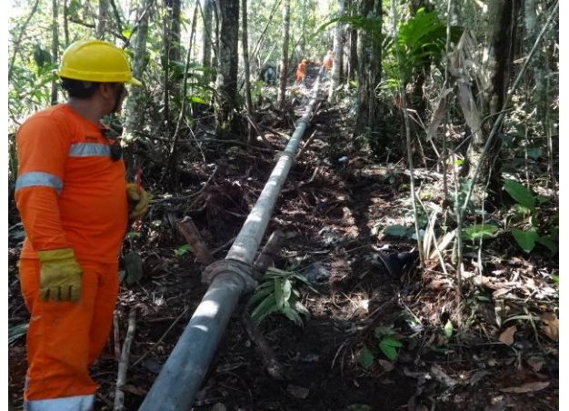
14 Recorrido por medio de tubería.
