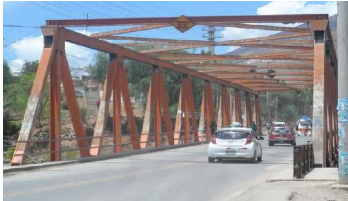
SUPERESTRUCTURA, PUENTE RETICULADO
