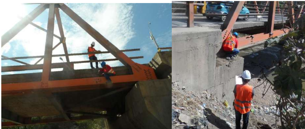
Fig. H.4. Recoleccion de datos a detalle de elementos que compone del puente
