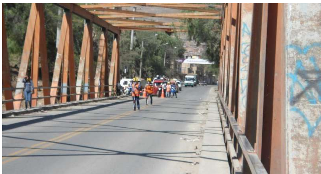
Fig. H.6. verificación de existencia de contraflecha del puente
