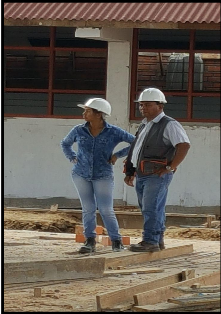
MONITOREANDO LA OBRA
