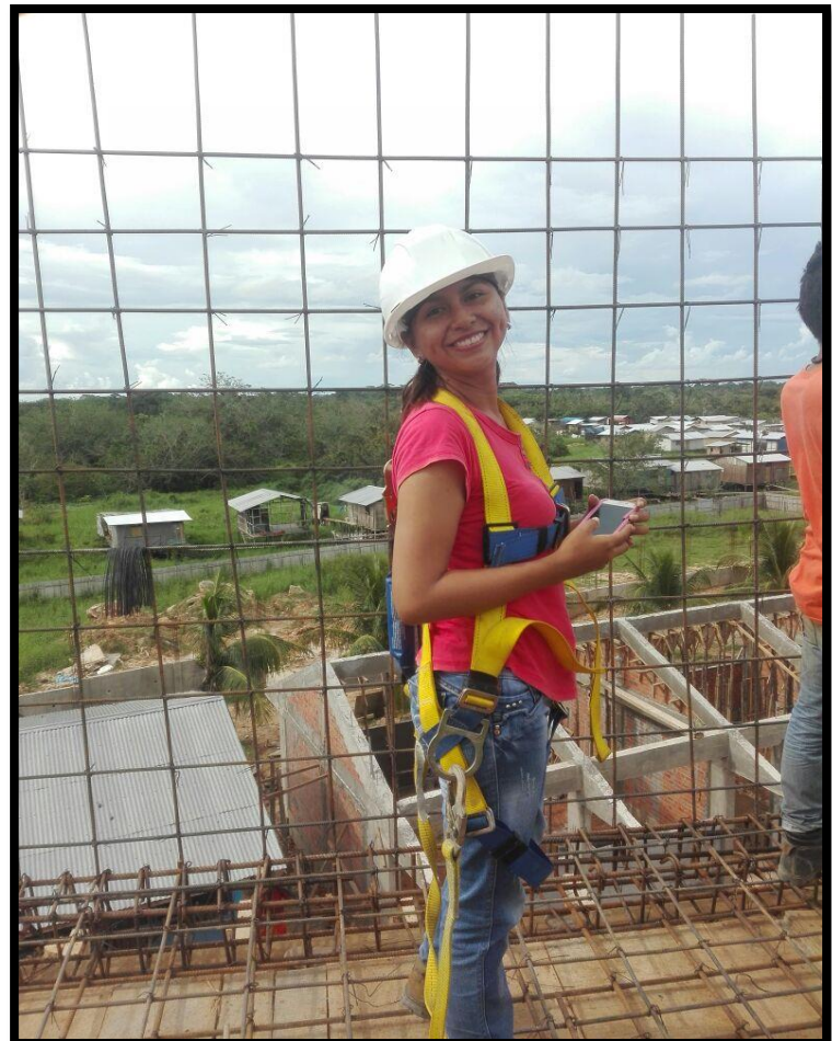
MONITOREANDO LA OBRA
