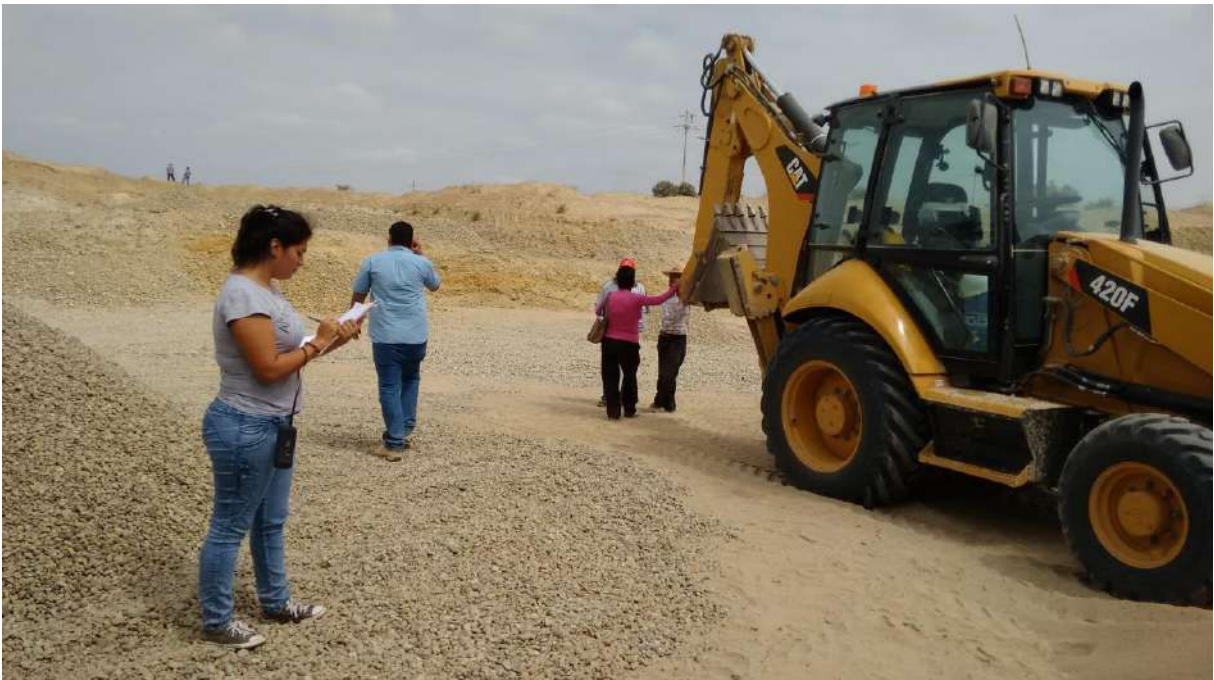
FOTOGRAFÍA N° 11: Inspección del área del Proyecto Alfa 2014
