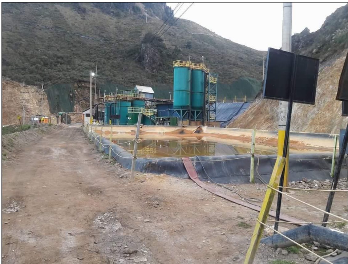
Figura 36: Drenaje mina saliente de la planta San Pedro.
