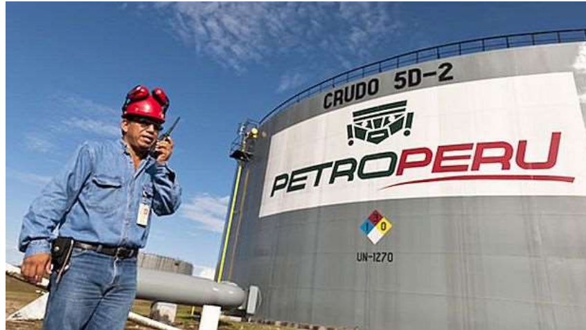
Planta de asfalto de PETROPERU
