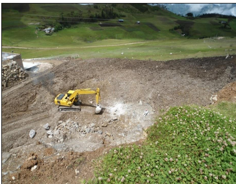
Figura 25: Excavadora en Ítalo. Fuente: Elaboración propia, (2017).
