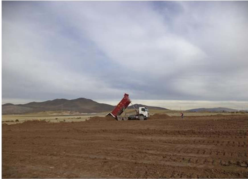
Descarga de arcilla en Zona 1
