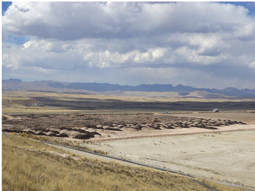
Descarga de top soil 50 % + GM 50% en Zona 1
