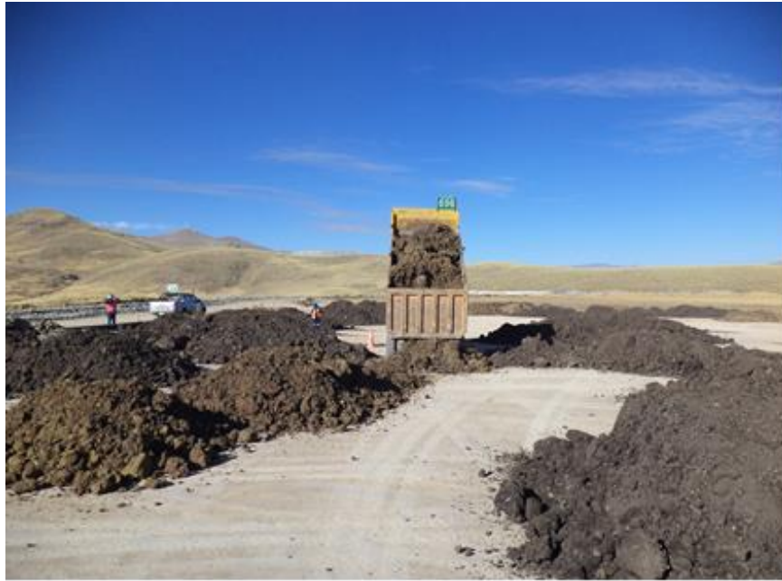
Descarga de top soil en Zona 1
