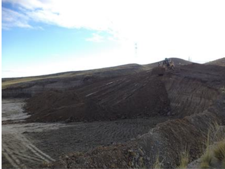
Cierre de primera cantera de arcilla de Zona 1
