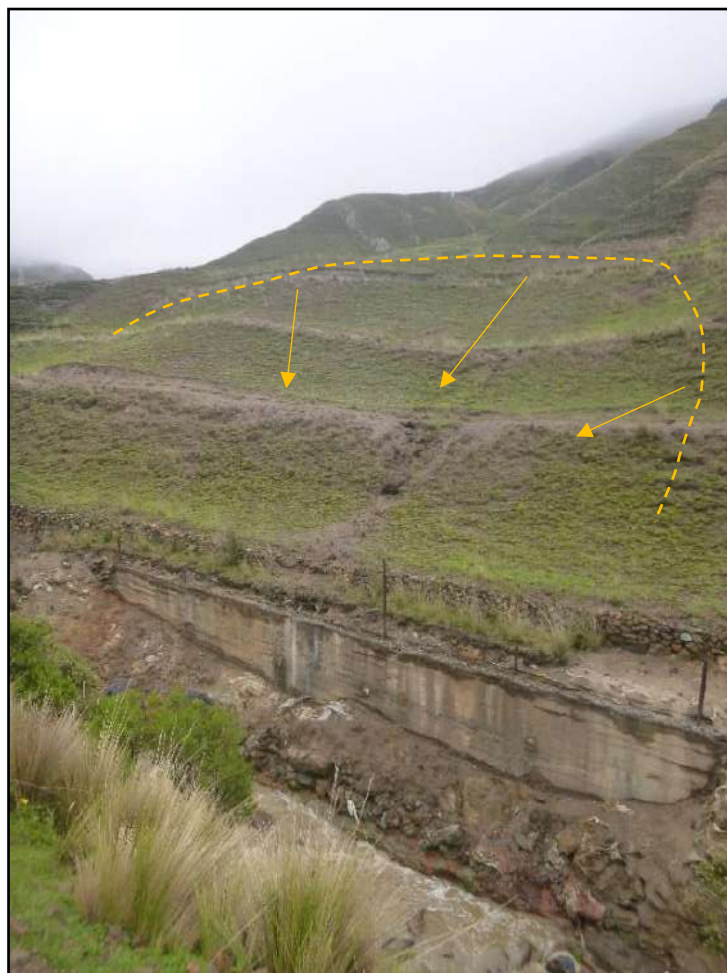
Fotografía 9 Vista del muro de concreto del DR N°2
