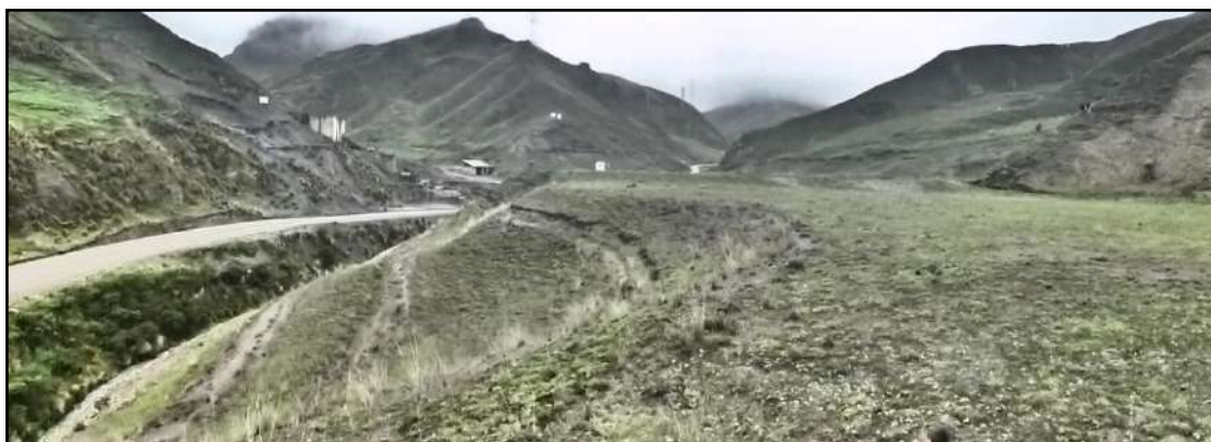
Fotografía 5 Vista de los taludes externos del DR N°1
