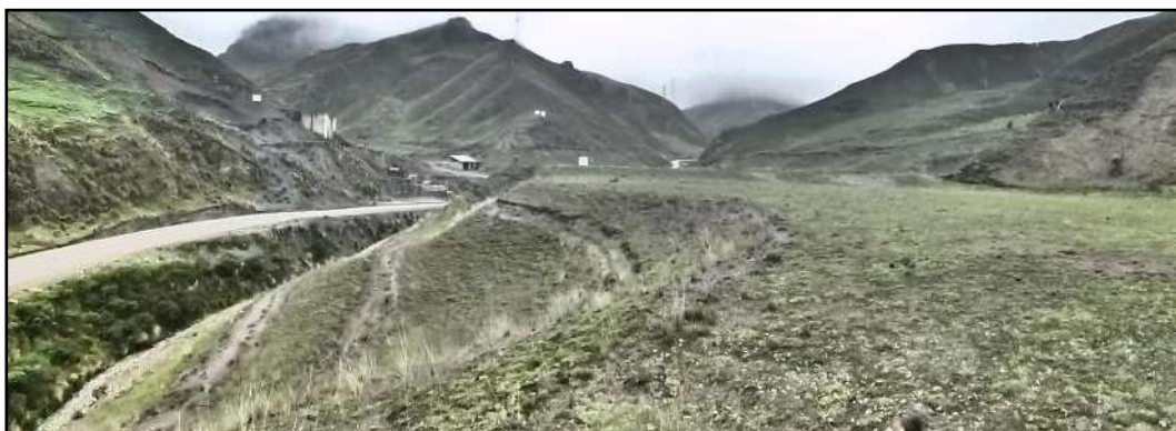
Fotografía 8 Vista de Taludes Externos del DR N°2
