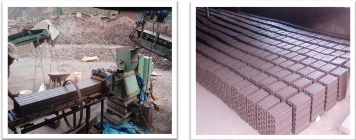
Figura 24 Proceso de moldeo de ladrillos tipo blocker .
